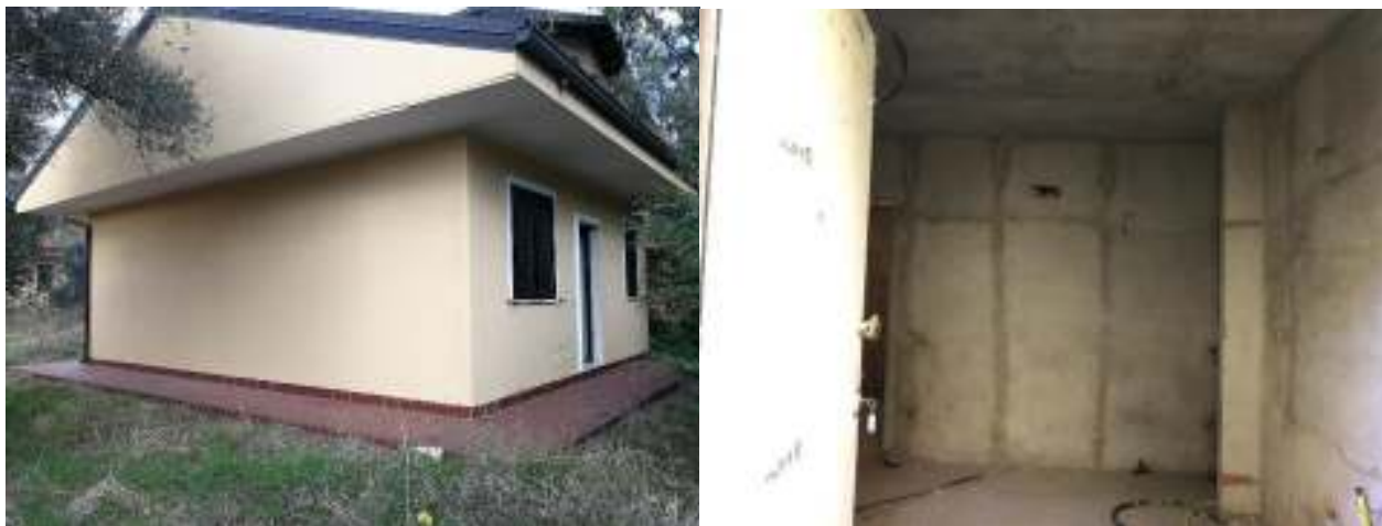
FOTO 19 e 20 – Facciata sud-est e cucina-soggiorno del subalterno 25 interno A4.
