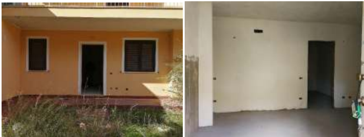
FOTO 8 e 9 – Facciata est e cucina-soggiorno subalterno 17 interno B3.
