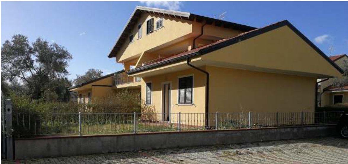
FOTO 1 – Fabbricato lotto B, composto da più appartamentini.
