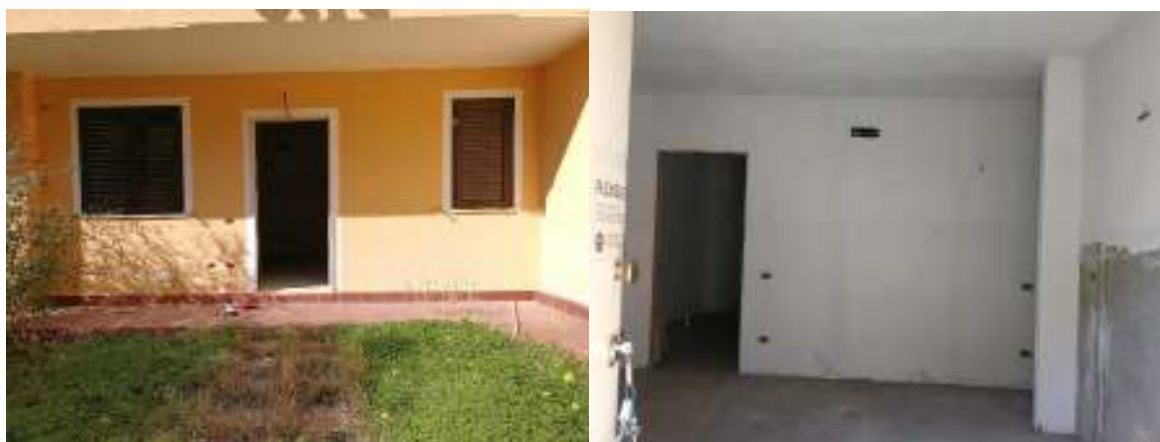
FOTO 6 e 7 – Facciata est e cucina-soggiorno subalterno 16 interno B2.
