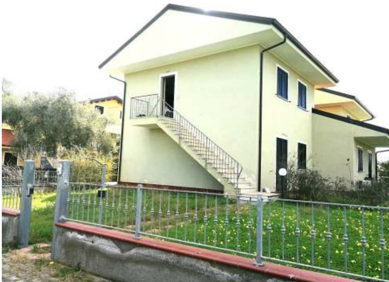
FOTO 29 – Fabbricato lotto C, composto da più appartamentini.
