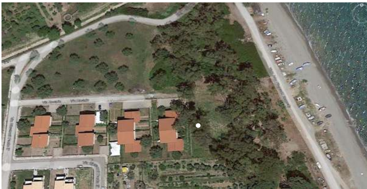
IMMAGINE SATELLITARE 1 – Complesso residenziale a circa mt 100 dal mare, formato da n. 4 lotti costituiti ognuno da un fabbricato composto da più appartamento.
