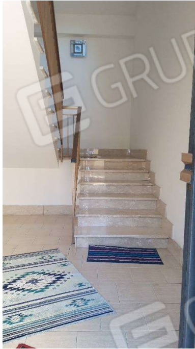
Scala di accesso
