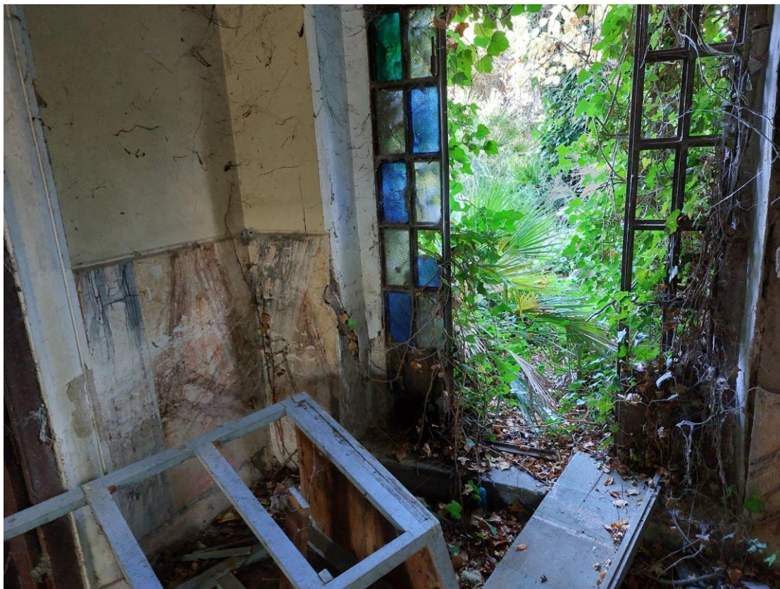
Foto N. 4: Ingresso dalla corte esterna al sub.3 (Lotto 1)
