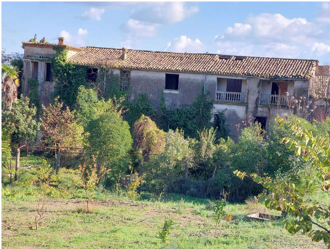
Foto N. 3: Prospetto Ovest dell'immobile dove è ubicato il sub.3 e il sub. 5 (Lotto 1)
