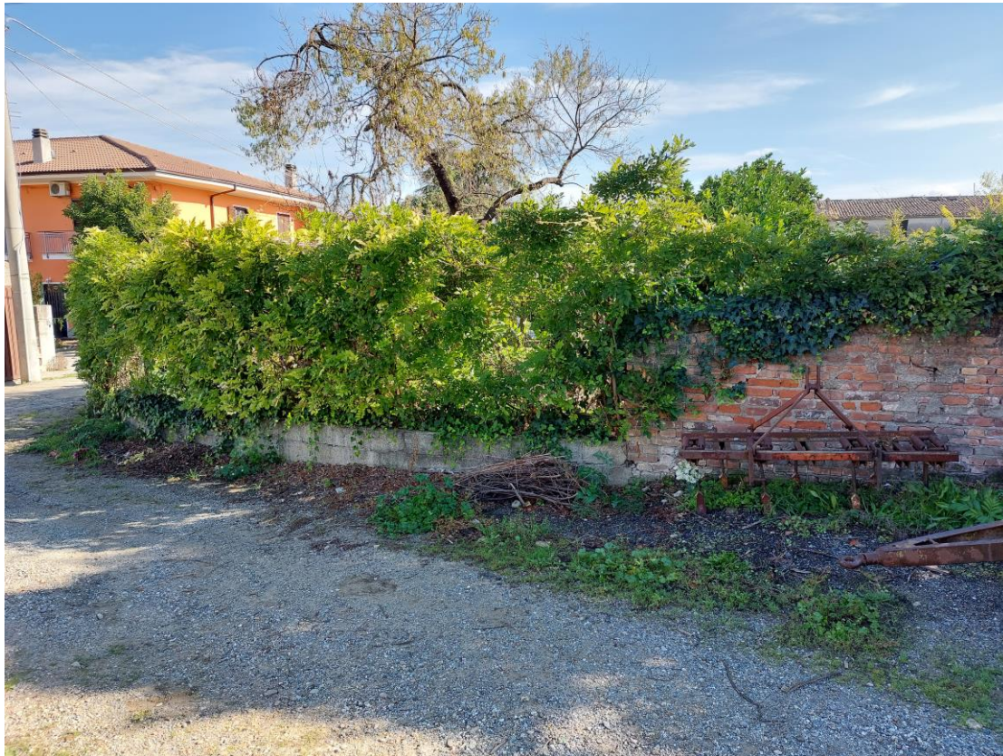
Foto N.17: Fronte Ovest dell'immobile identificato con la particella 27 (Lotto 1)
