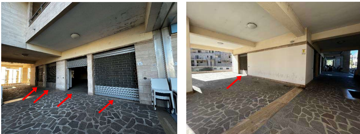
Figura 4: Foto a sx: Accessi all'immobile pignorato da via Rossini; foto a dx: Accesso secondario dal lato interno del fabbricato.
