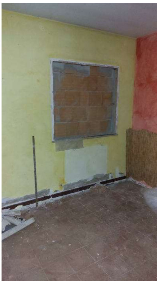
Foto n.34: Piano seminterrato – tavernetta
