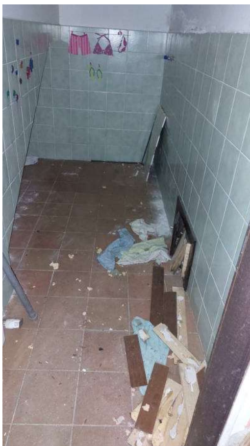
Foto n.38: Piano seminterrato – lavanderia
