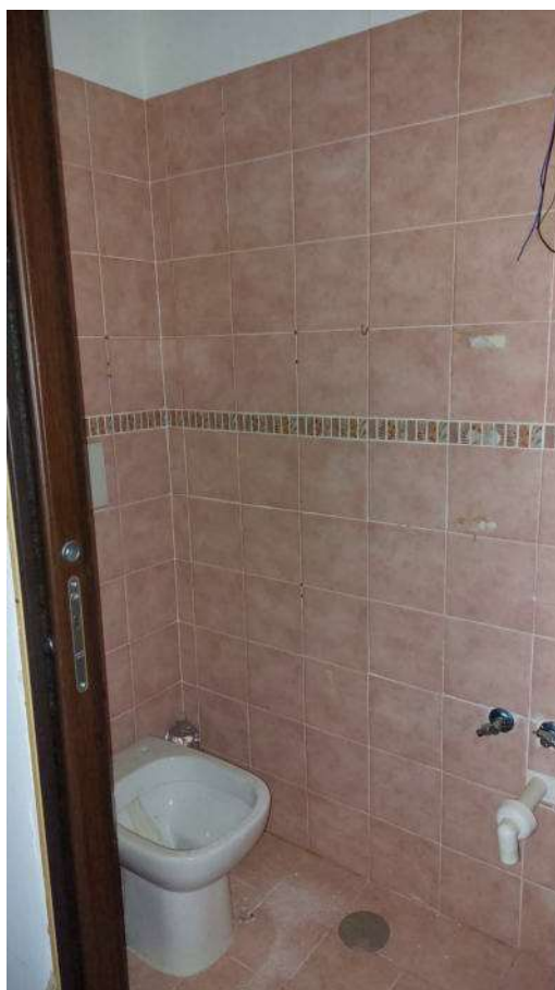
Foto n.16: Piano Terra – lavatoio - wc
