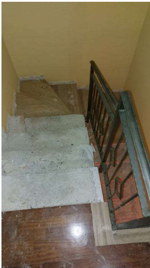
Foto n.27: Scale – Piano primo – Piano terra
