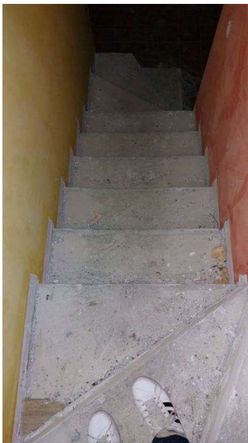
Foto n.31: Scale – Piano terra – Piano seminterrato
