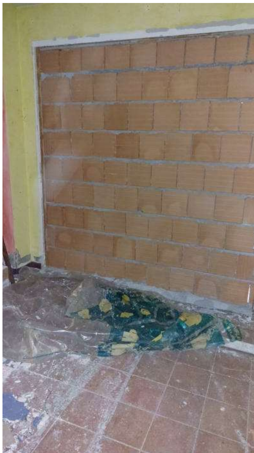
Foto n.33: Piano seminterrato – tavernetta
