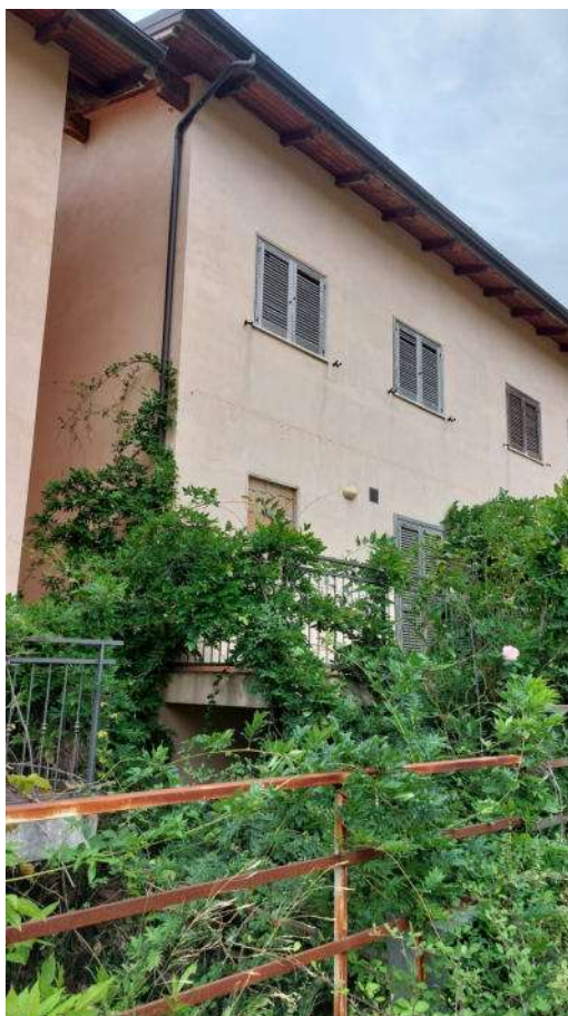
Foto n.5: Vista generale esterna – lato sud-ovest
