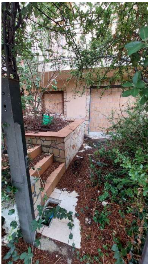
Foto n.7: Piano seminterrato – Vista generale esterna
