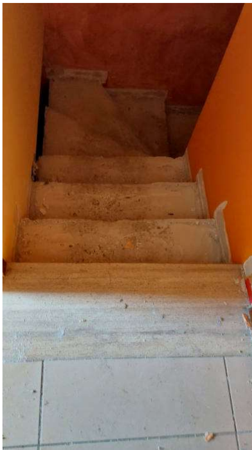
Foto n.29: Scale – Piano terra – Piano seminterrato
