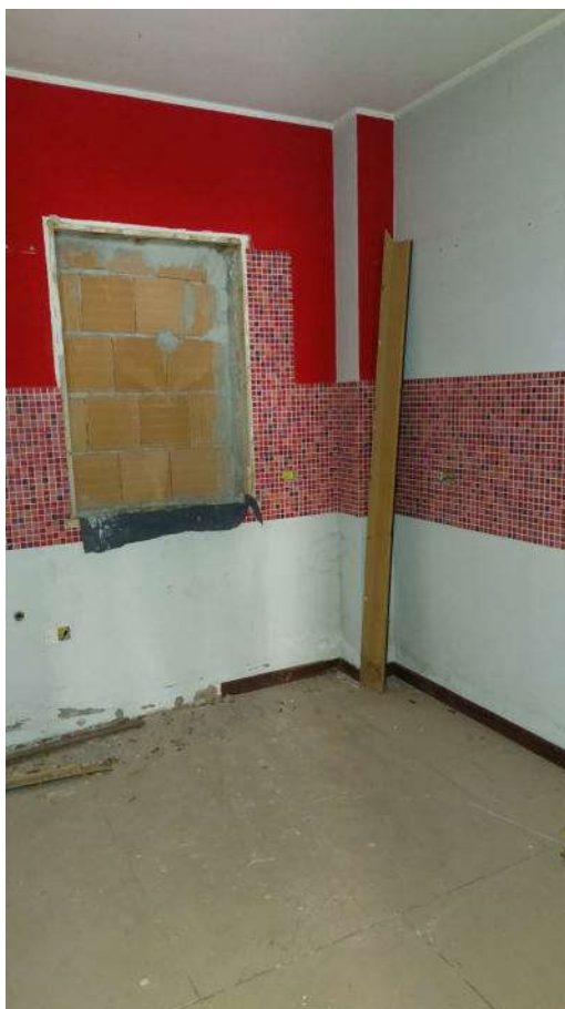
Foto n.15: Piano terra – cucina
