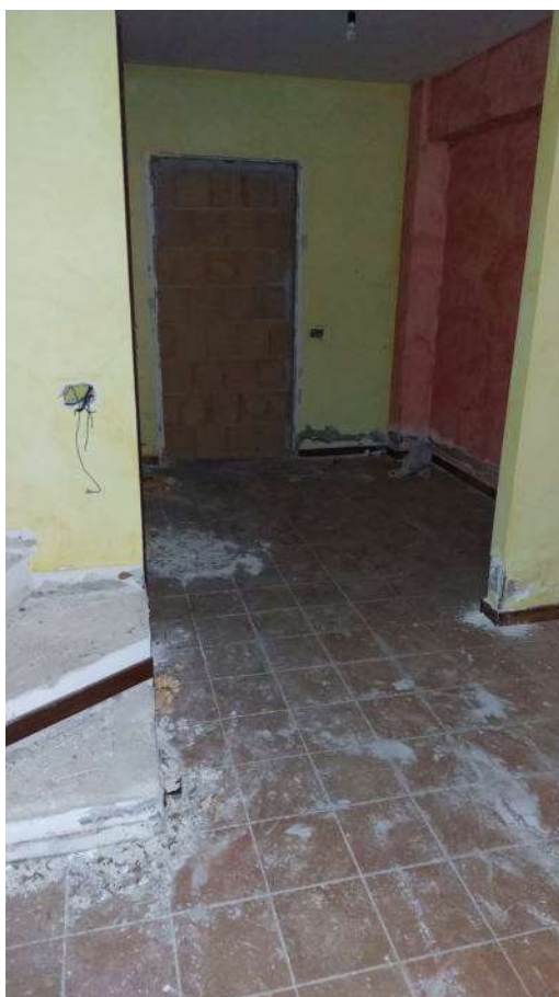
Foto n.36: Piano seminterrato – tavernetta
