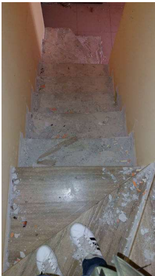
Foto n.28: Scale – Piano primo – Piano terra
