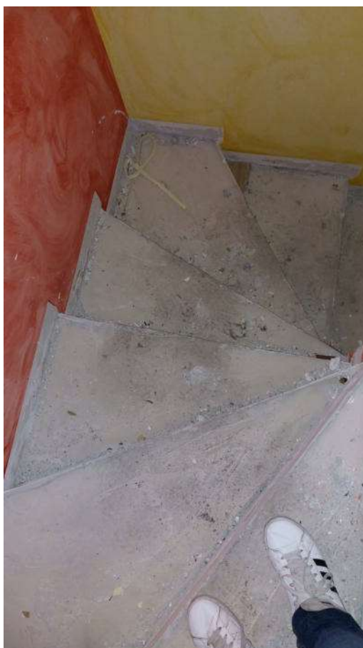
Foto n.30: Scale – Piano terra – Piano seminterrato
