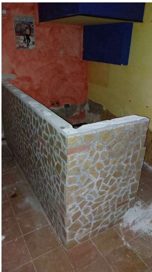
Foto n.35: Piano seminterrato – tavernetta
