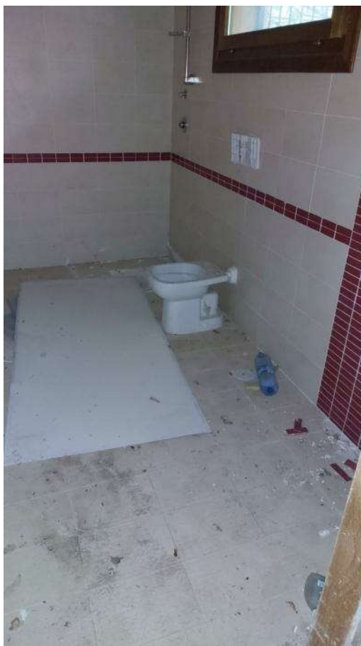
Foto n.37: Piano seminterrato – bagno
