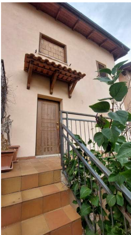
Foto n.6: Vista generale esterna – Entrata su ballatoio
