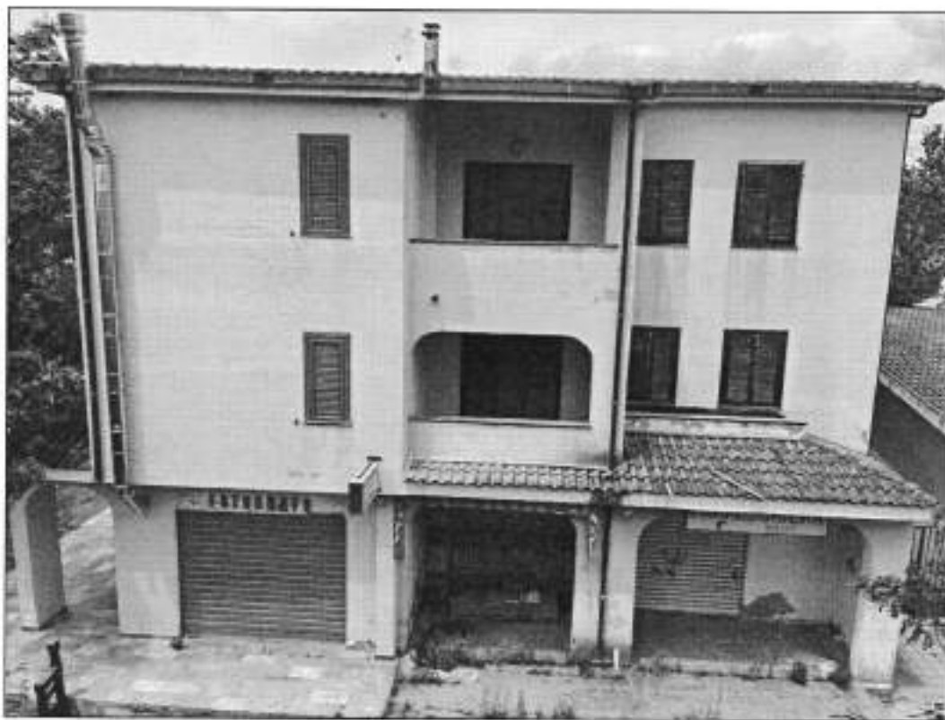
Fig. 10 – Fabbricato part. 823 – Palazzina K
