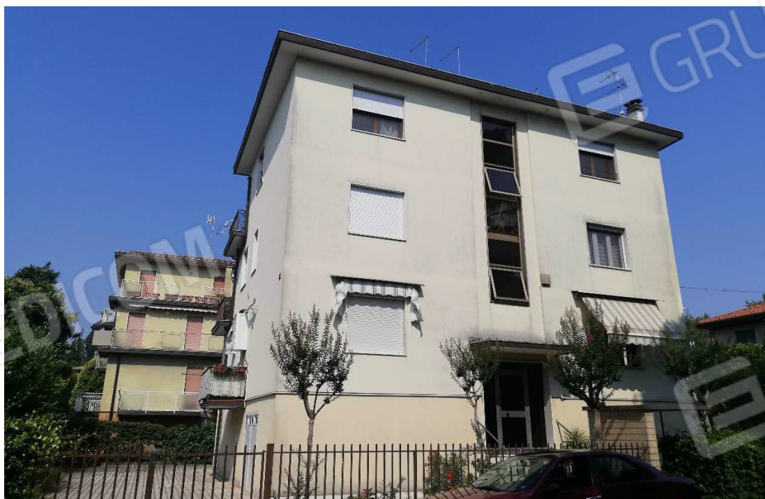
Foto n. 2: vista del fabbricato da sud-est
