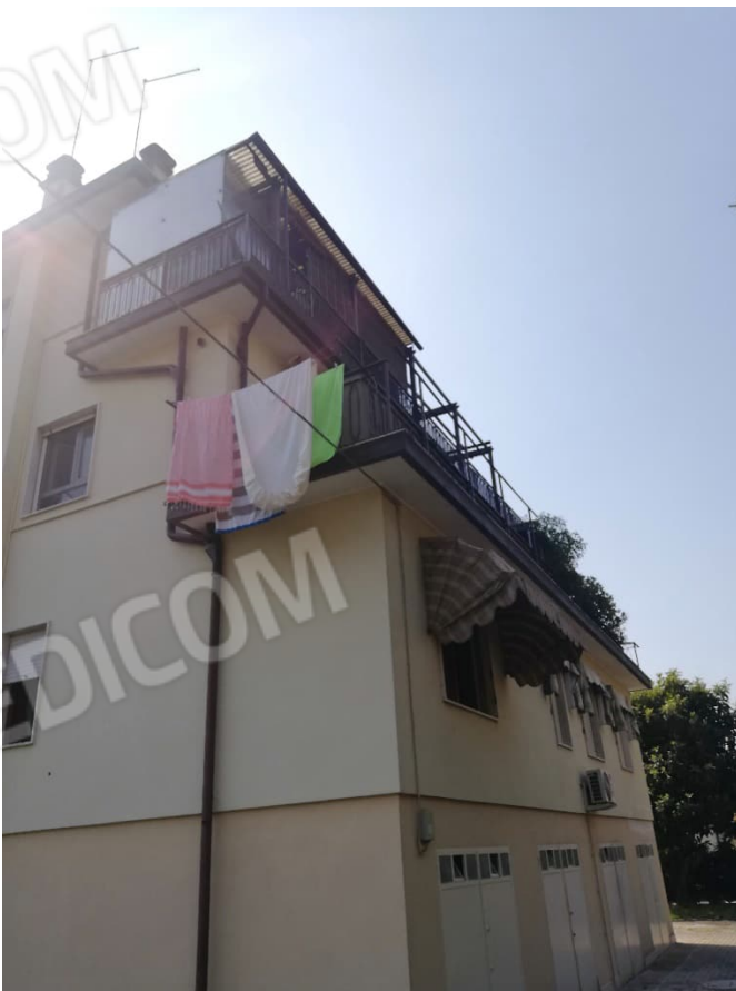
Foto n. 4: Vista del fabbricato- ovest
