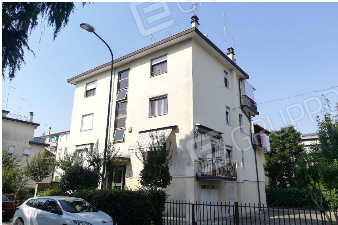
Foto n. 1 Vista del fabbricato da nord-est
