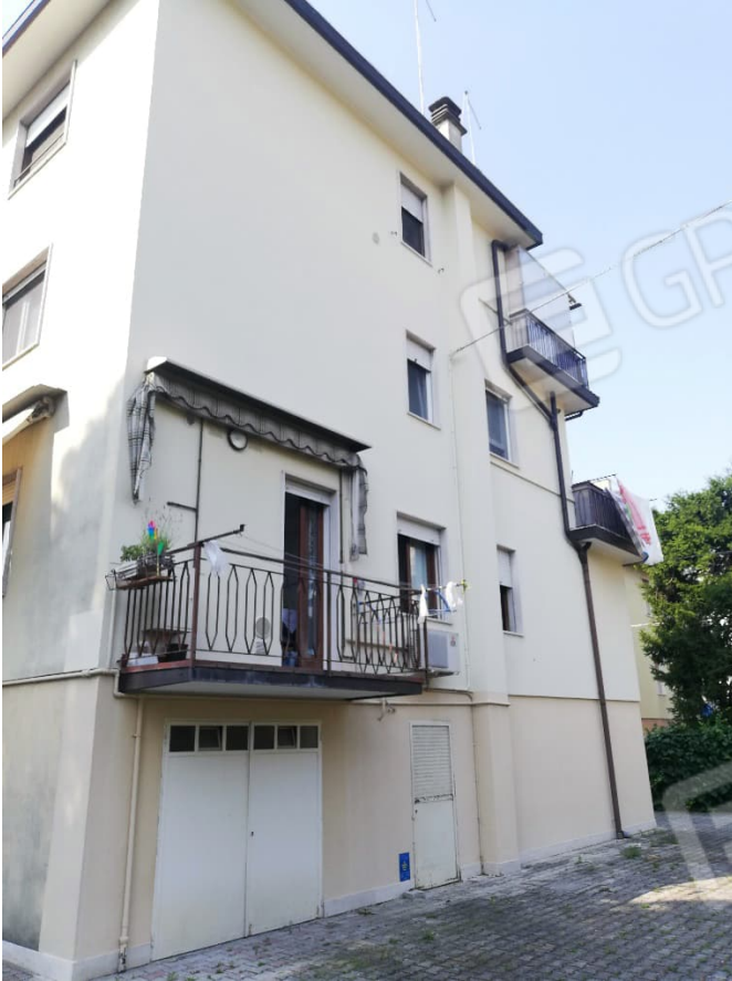
Foto n. 3: vista del fabbricato -nord
