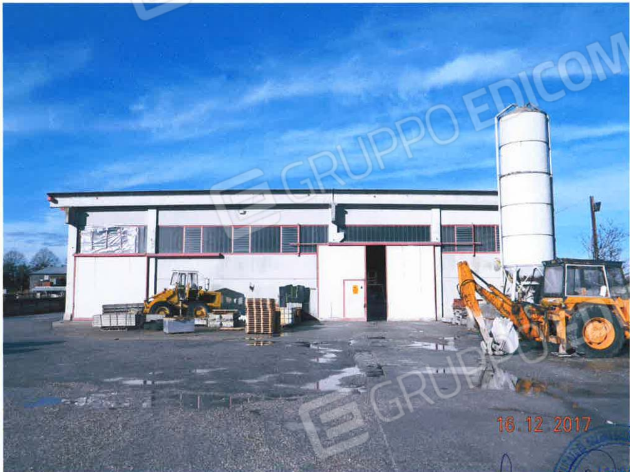
LOTTO 1 – Capannone ad uso artigianale (particella 46, sub. 5)
