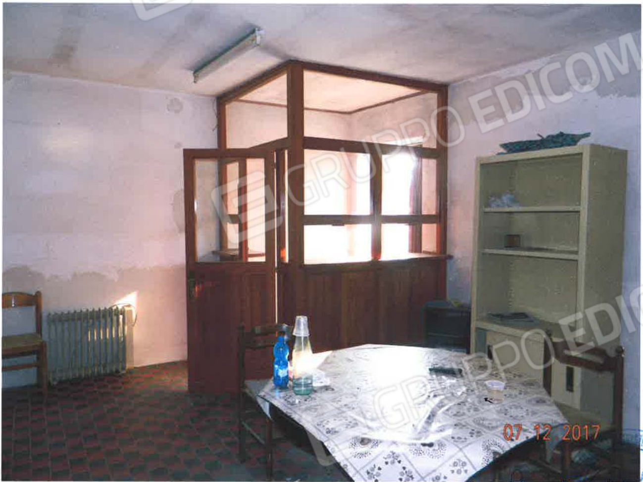
LOTTO 1 – Magazzino (particella 46, sub. 7) – piano terra, interno
