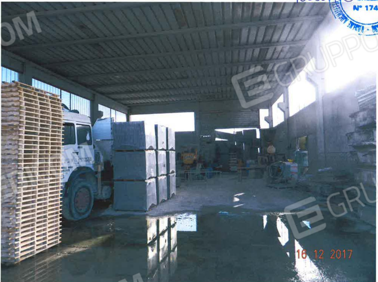
LOTTO 1 – Capannone ad uso artigianale (particella 46, sub. 6) – interno
