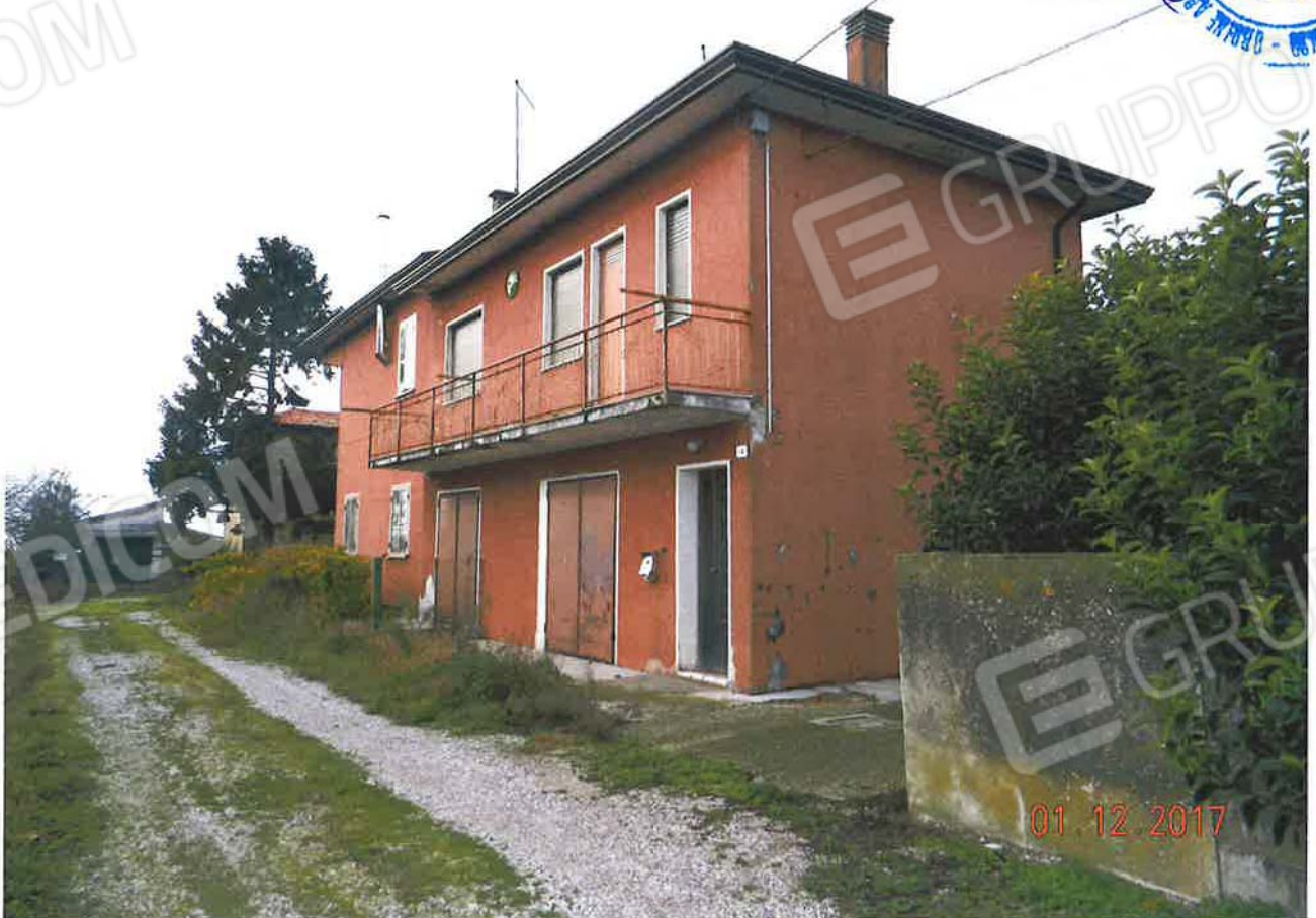
LOTTO 2 – Abitazione piani terra e primo (sub. 3) – ingresso
