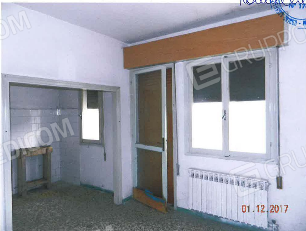
LOTTO 2 – Abitazione (sub. 3) – piano primo, interno
