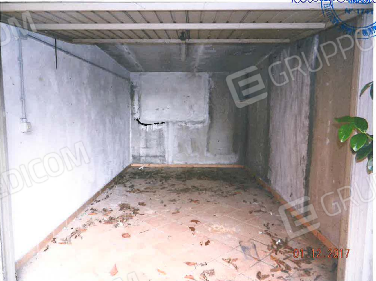
LOTTO 2 – Garage (sub. 7) – piano terra, interno
