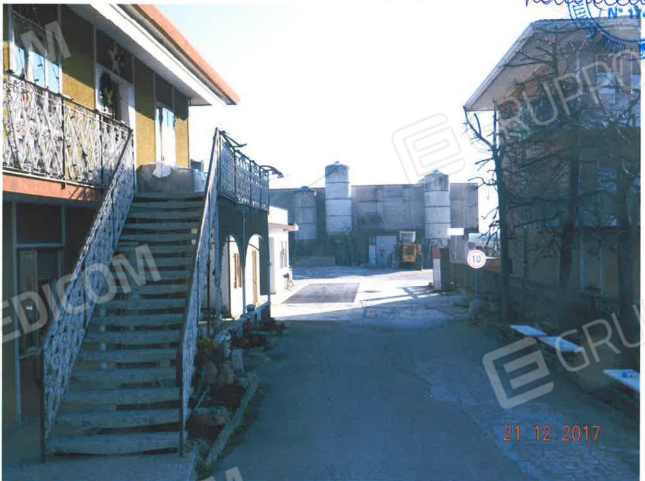
LOTTO 1 – Abitazione piano primo (particella 32, sub. 3) - ingresso
