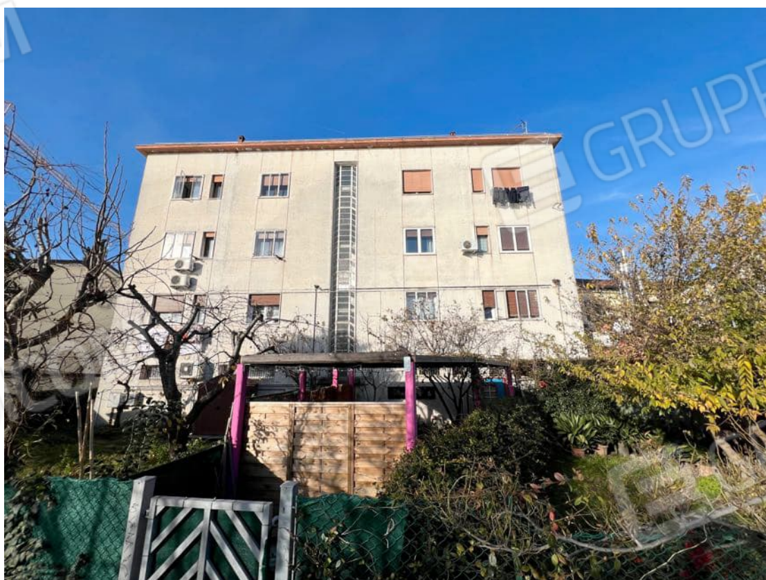
Foto n. 4 Prospetto est del fabbricato
