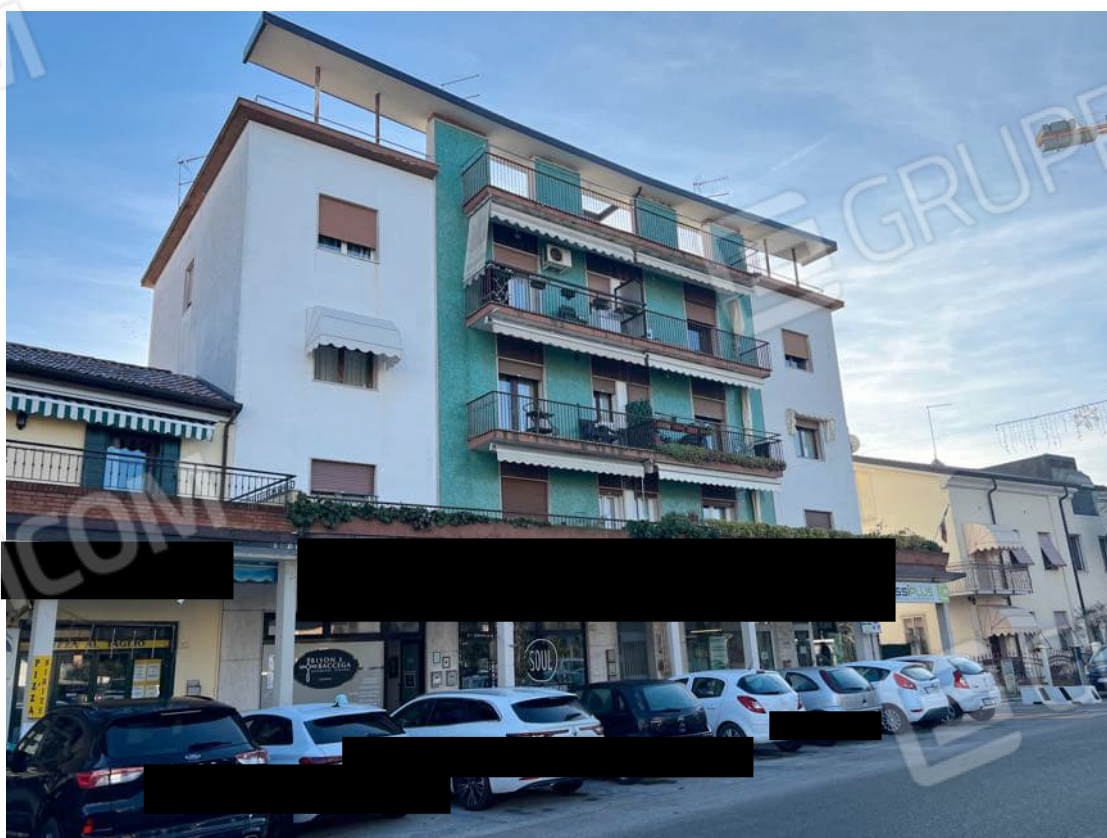
Foto n. 2 Prospetti nord e ovest del fabbricato su Piazza della Repubblica
