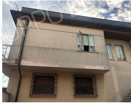
Vista appartamento da Via Garibaldi
