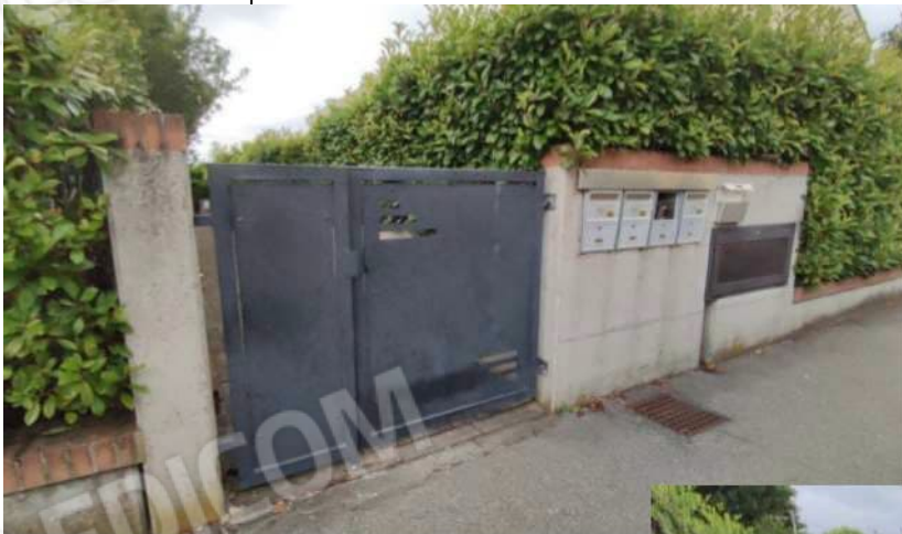
Lato est – ingresso Pedonale
