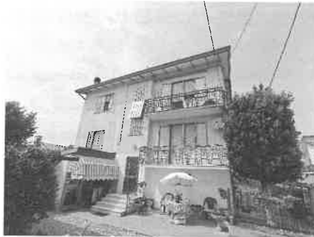
Fig. n. 3 _Panoramica fabbricato oggetto di disamina
