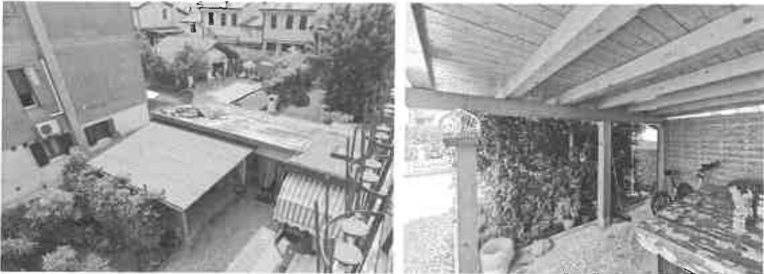
Fig. n. 10_Panoramiche della tettoia
