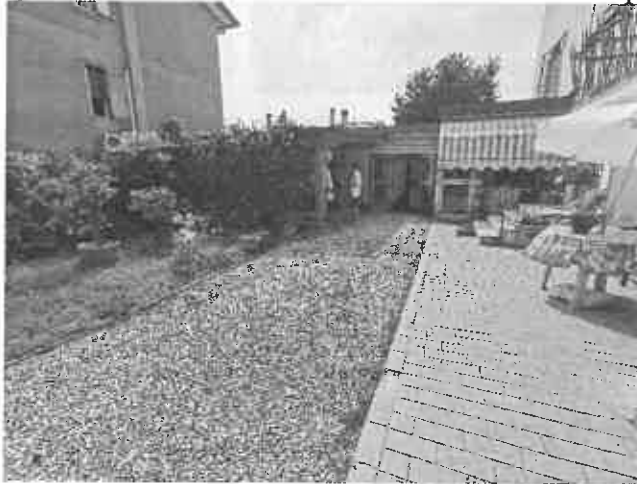
Fig. n. 6 _Panoramica fabbricato oggetto di disamina
