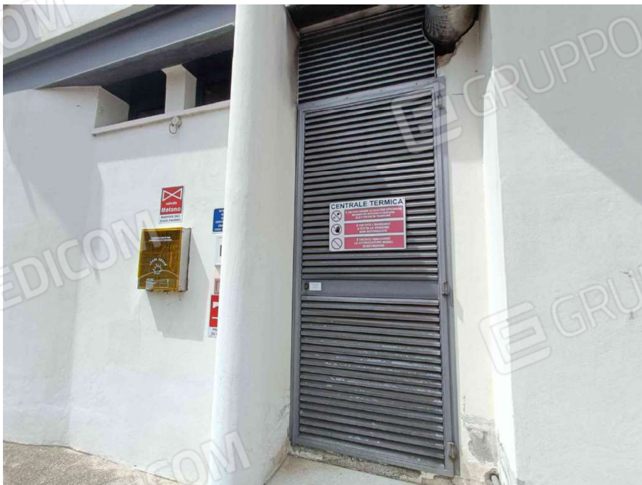
Foto 4 – Ingresso C.T. (prospetto Est)
