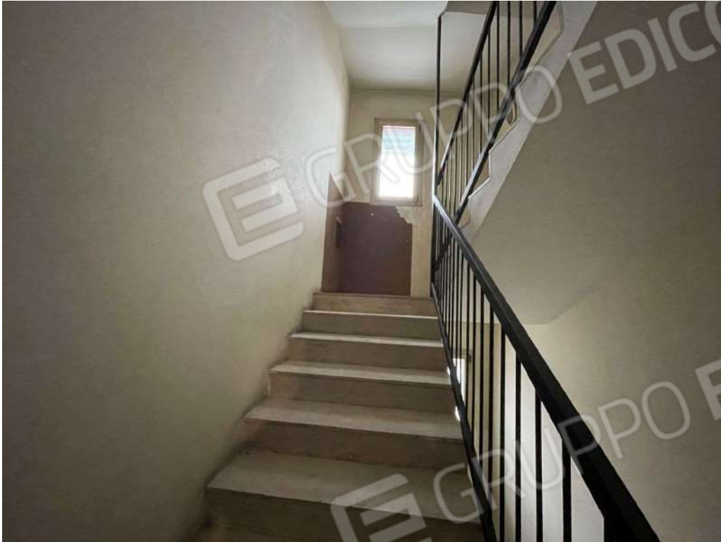
Particolare vano scala
