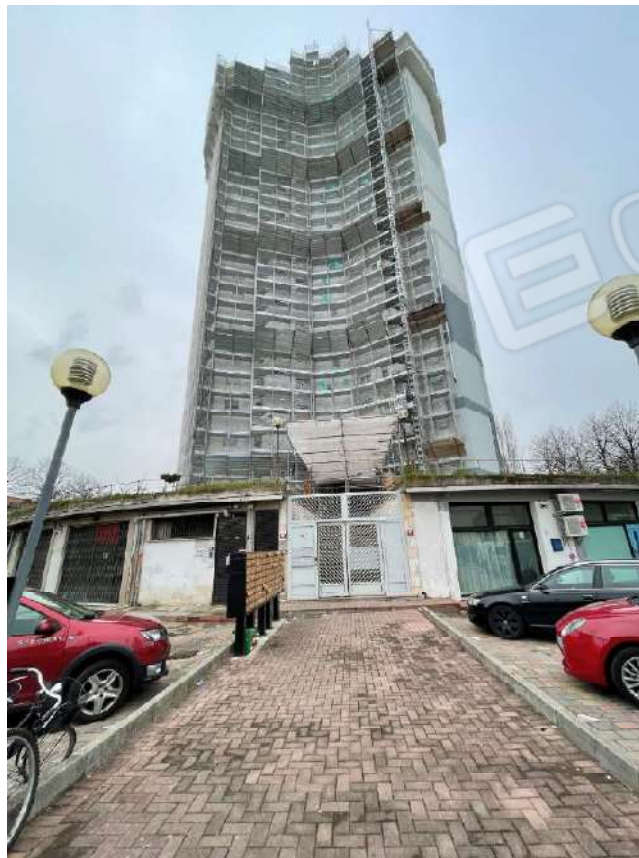
Particolare d'insieme con i lavori superbonus
