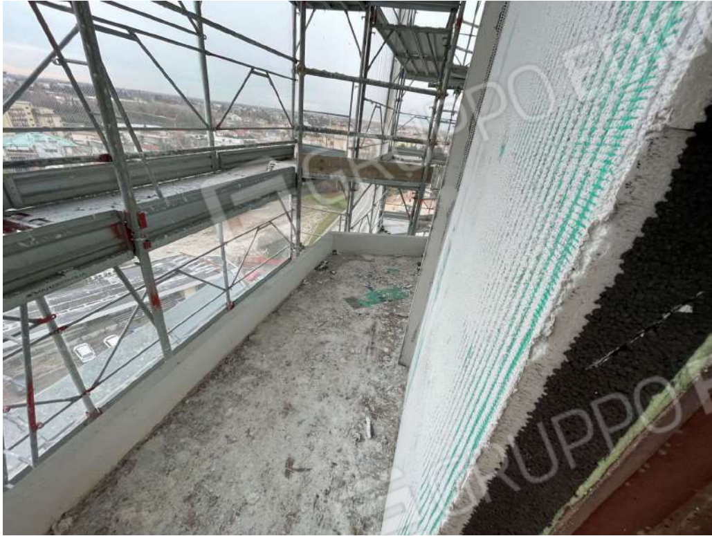
Particolare poggiolo ed opere di cappotto termico
