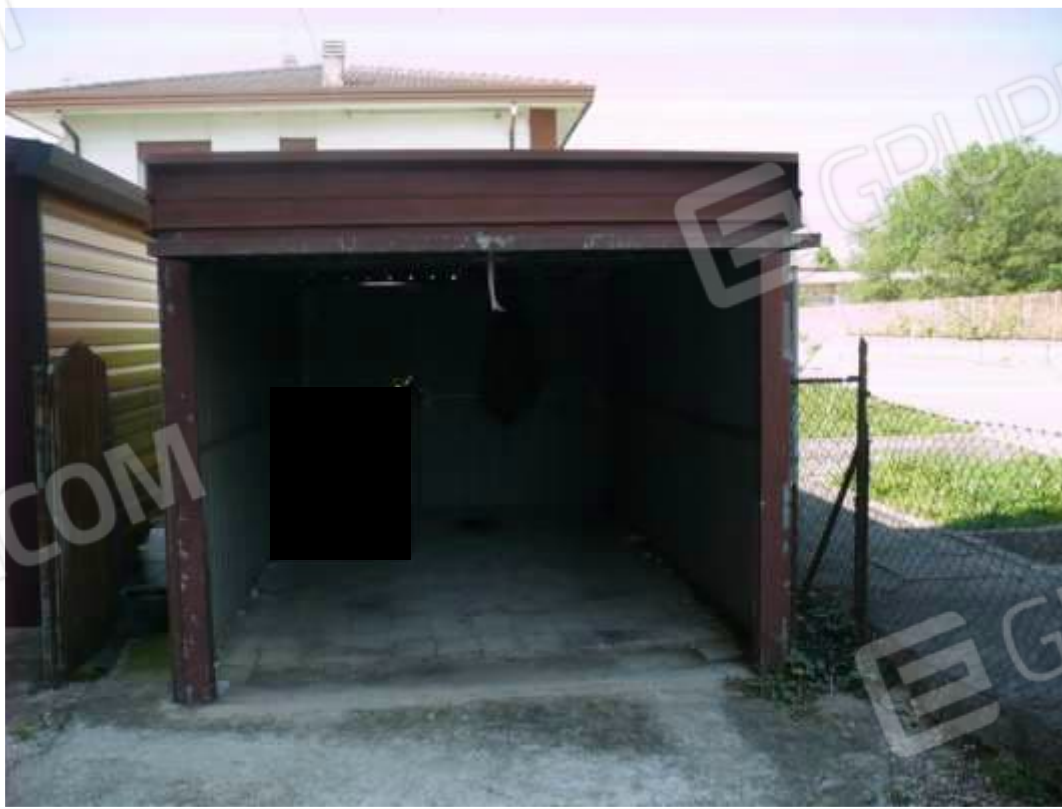
Garage prefabbricato esterno – particella 638
