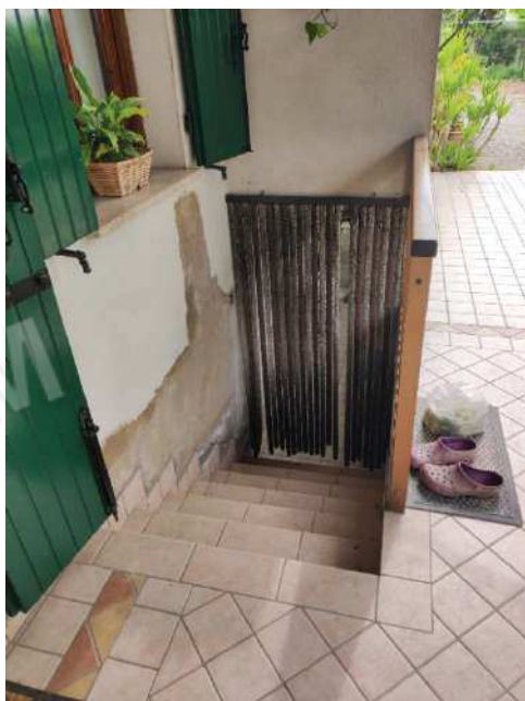
FOTO N. 22 (accesso esterno p. interrato)
