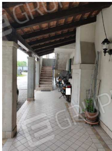
FOTO N. 23 (scala esterna piano primo)
