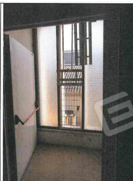
Foto n°89: Uscita di sicurezza P.1° a sud
