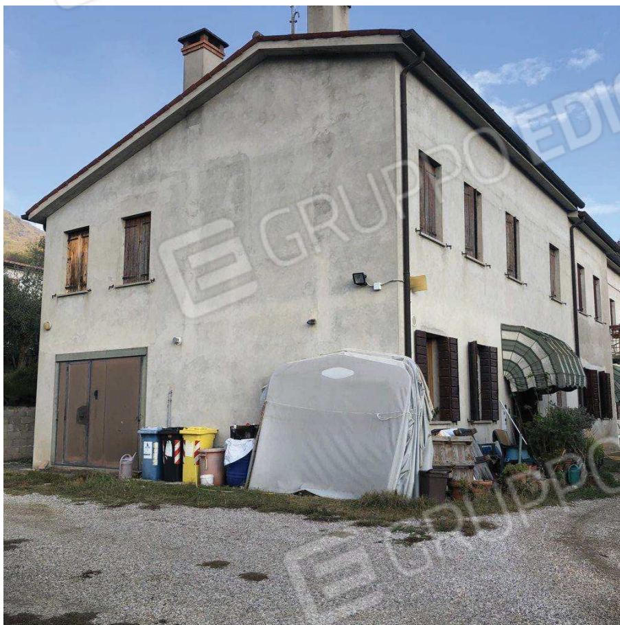
foto n. 3 – fabbricato bifamiliare (subb. 2 e 3) spigolo sud
