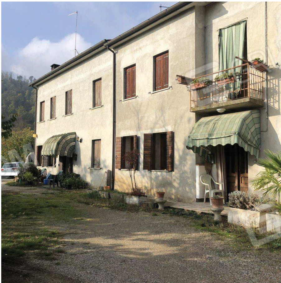
foto n. 2 – fabbricato bifamiliare (subb. 2 e 3) facciata sud-est
