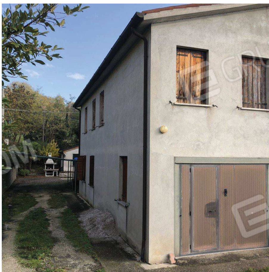
foto n. 4 – fabbricato bifamiliare (subb. 2 e 3) spigolo ovest
