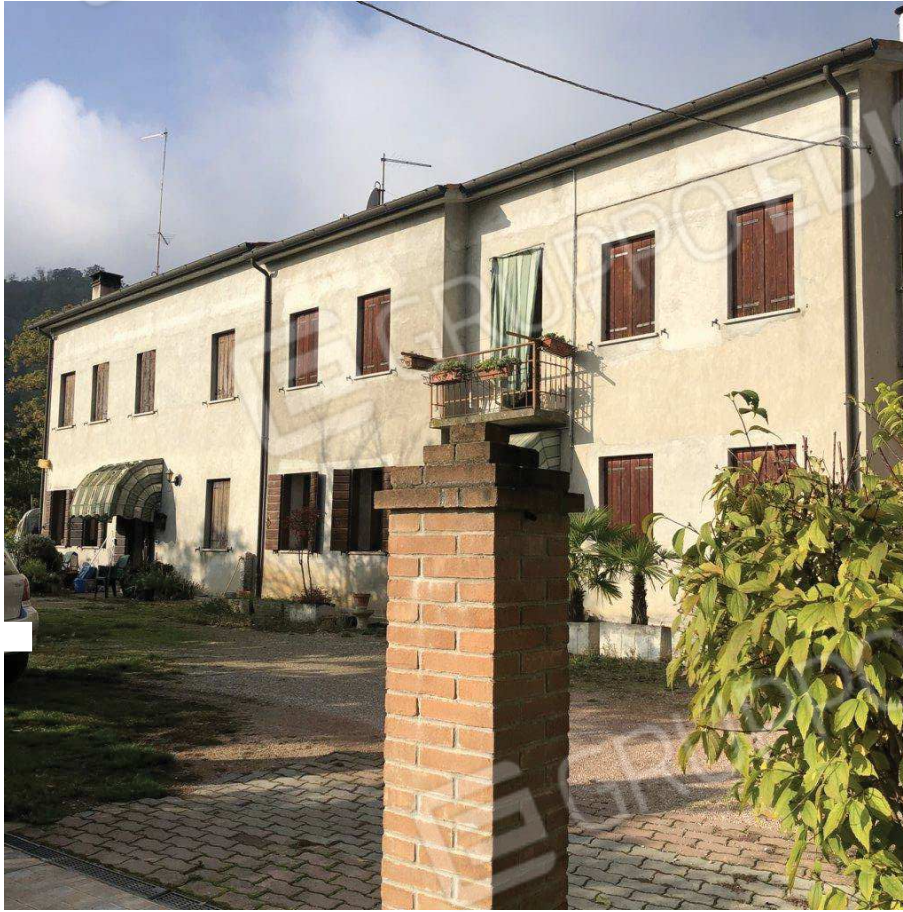
foto n. 1 – fabbricato bifamiliare (subb. 2 e 3) facciata sud-est
