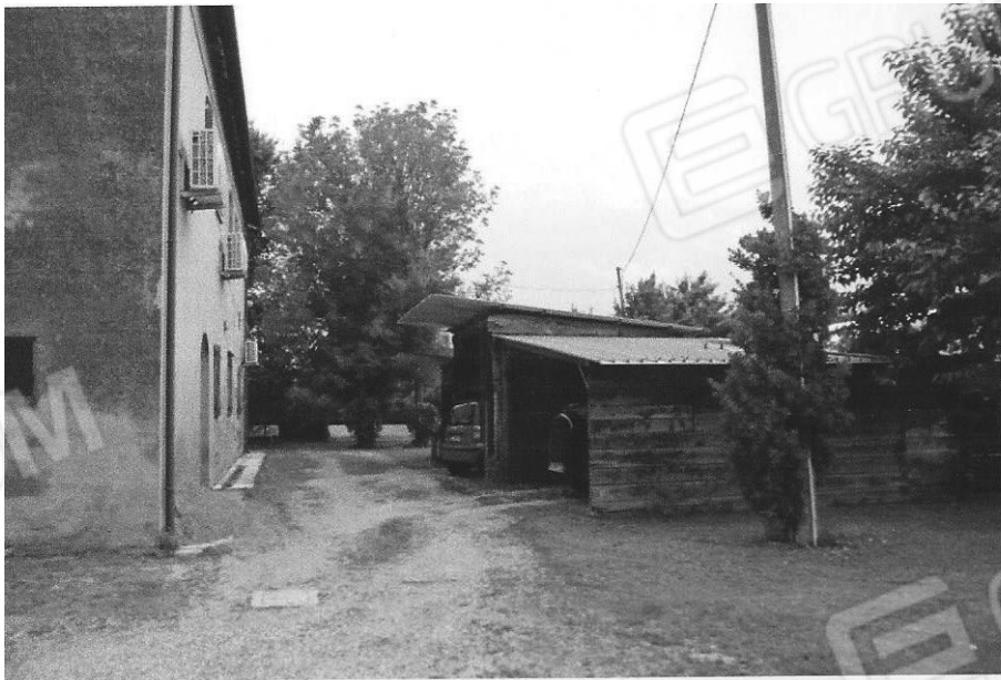
Lato ovest del cortile
