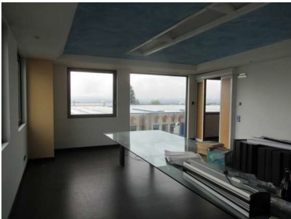
Foto n. 6 : C.F. Fg. 13 mapp. 708 - Piano primo, ufficio est
