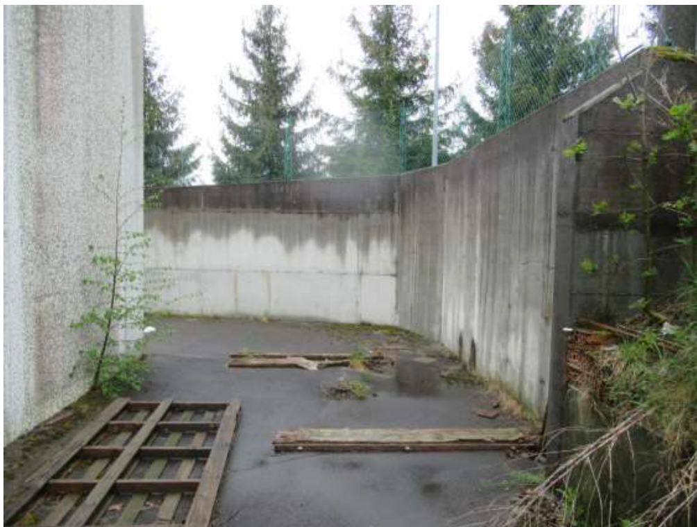
Foto n. 5 : C.F. Fg. 13 mapp. 708 - Muro a confine, lato nord
