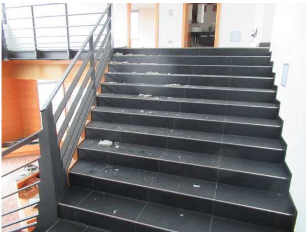
Foto n. 12 : C.F. Fg. 13 mapp. 708 - Scale di accesso al piano primo
