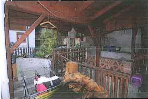
scala di accesso e corte comune
