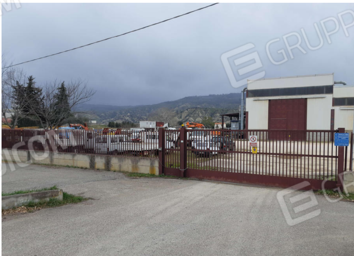
Figura 2: Accesso allo stabilimento. Area parcheggio mezzi
