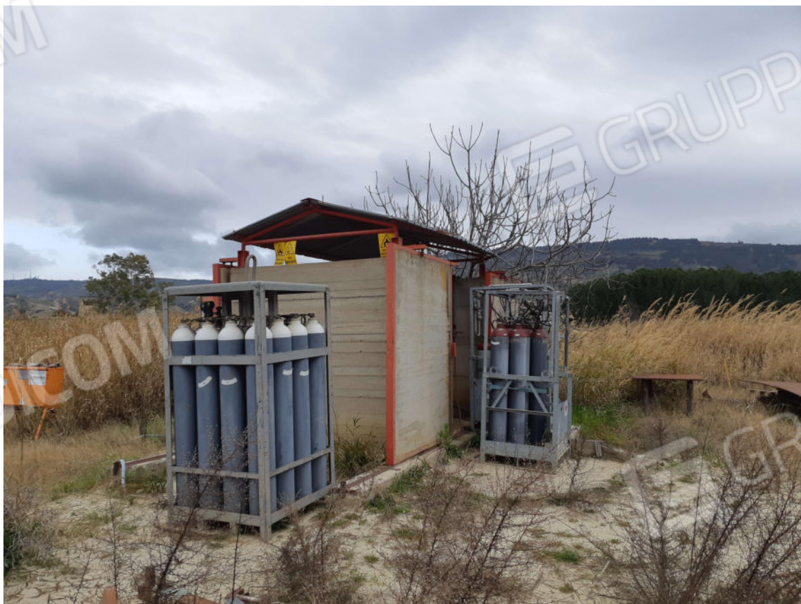
Figura 6; Deposito Gas Tecnici
