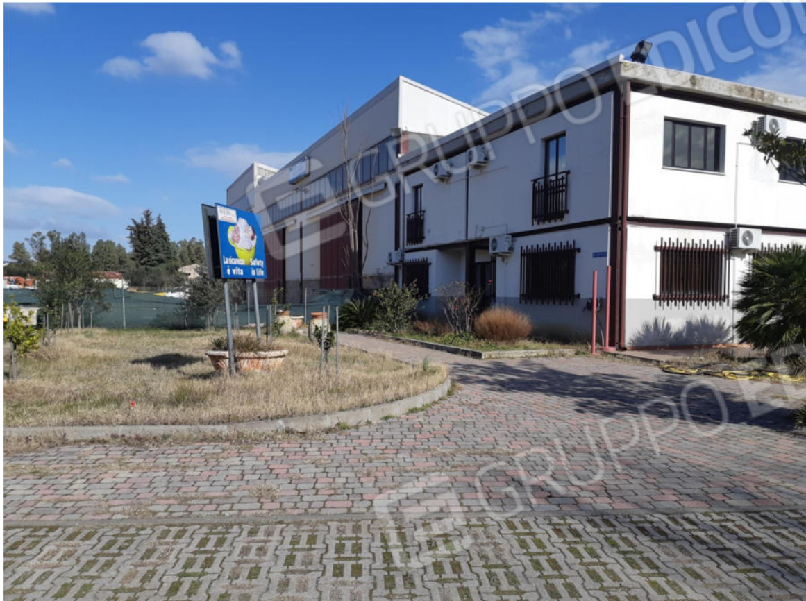
Figura 3: Capannone e Corpo Uffici
