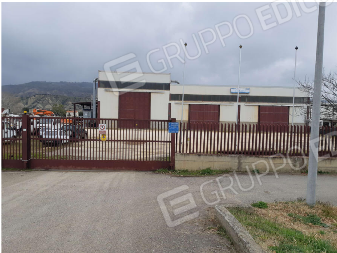
Figura 1. Accesso allo stabilimento
