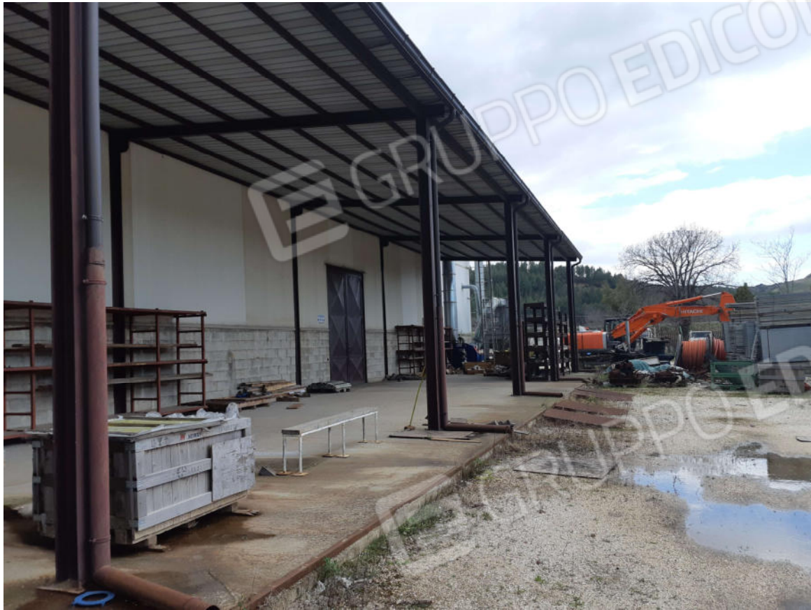
Figura 7: Tettoia afferente al capannone ubicata sul fronte N-O
