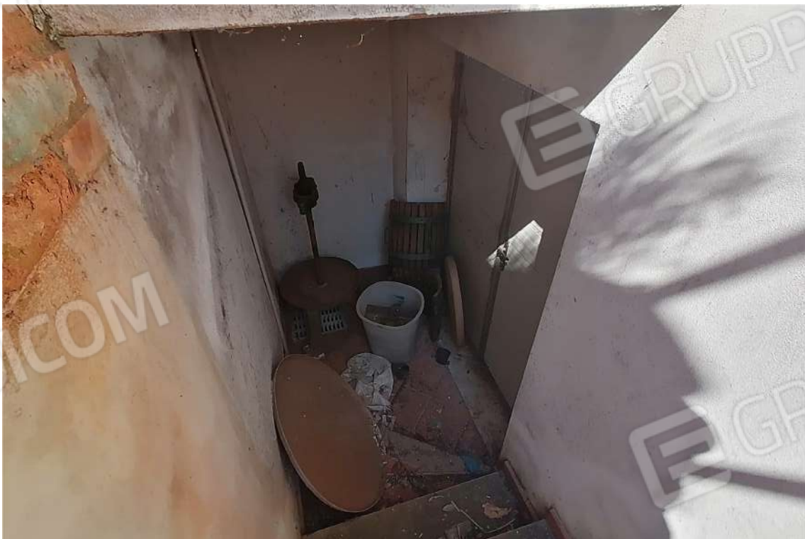
FOTO 18 – Vista esterna ingresso cantina
