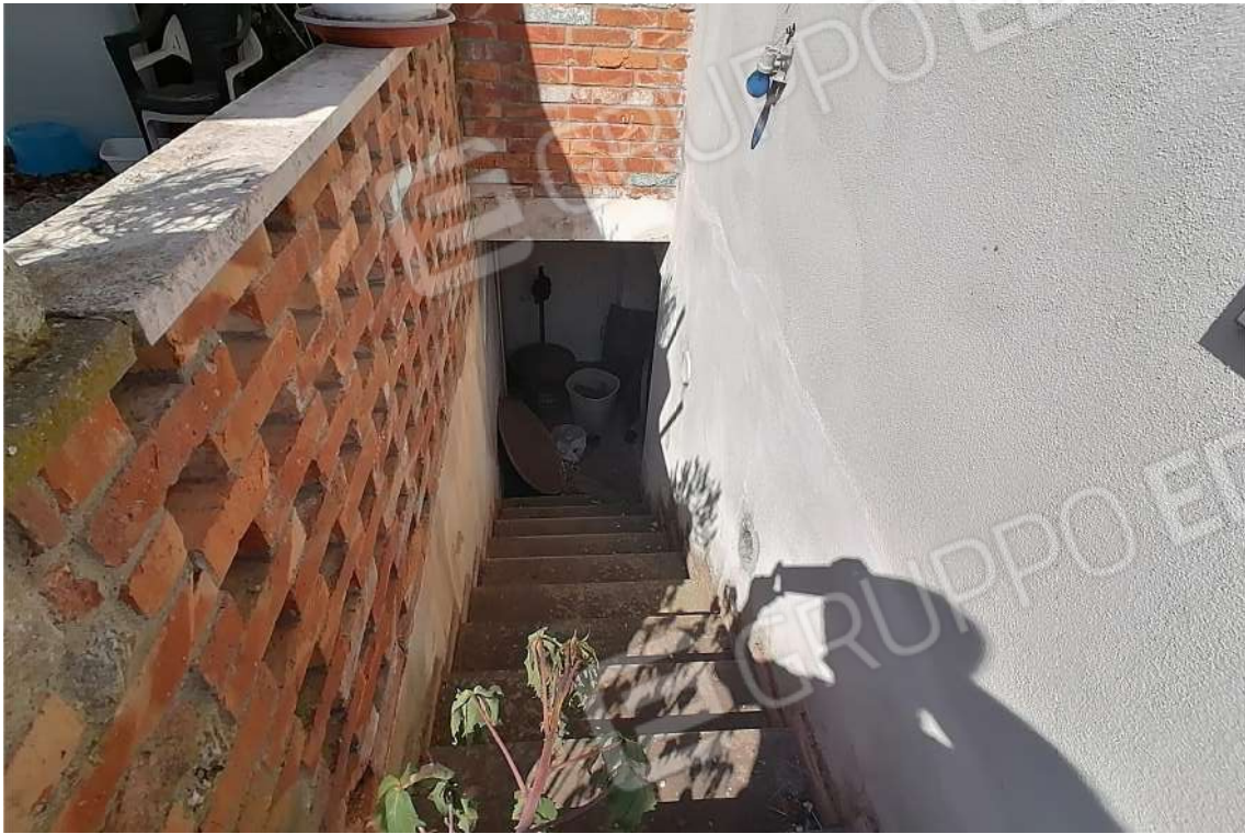
FOTO 17 – Vista esterna – scale accesso cantina
