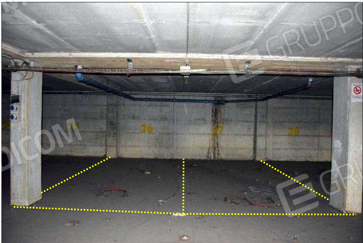
FOTO 6 – SUB 47 (POSTO 26) / SUB 48 (POSTO 27)
