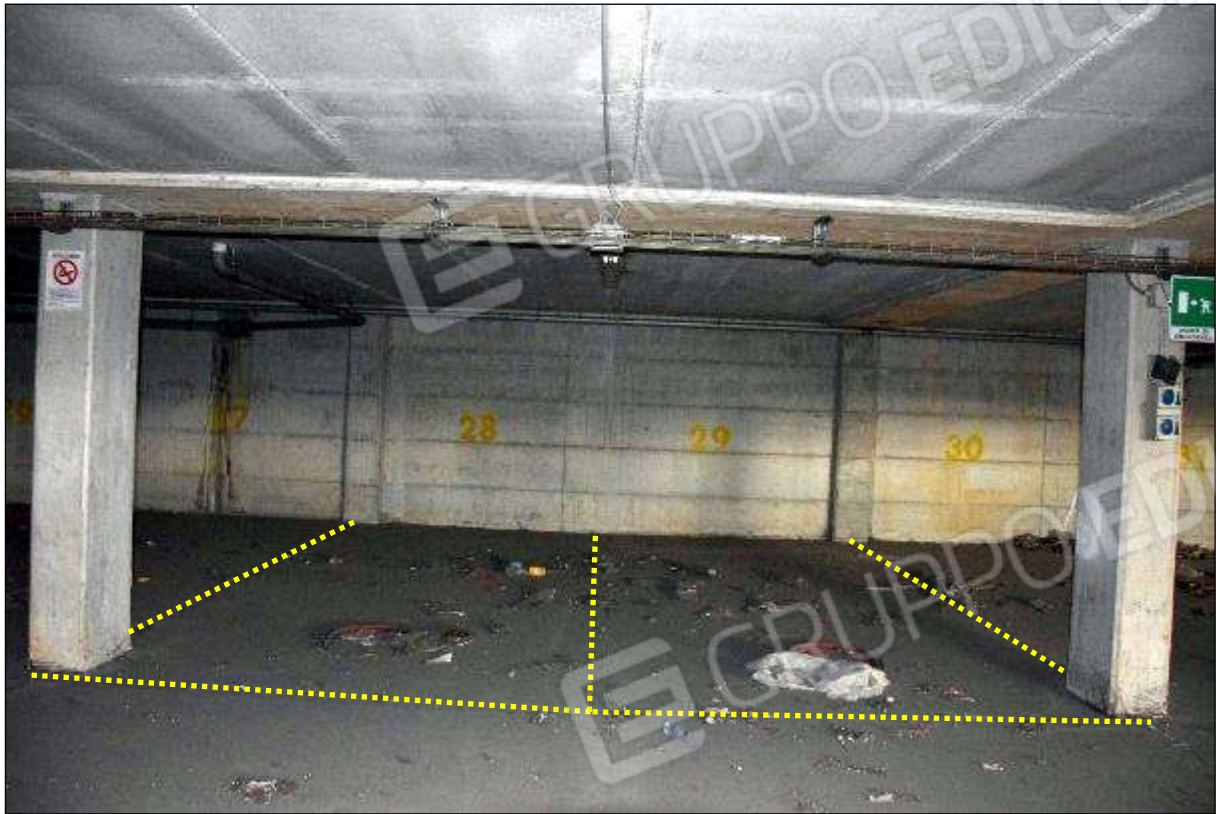
FOTO 7 – SUB 49 (POSTO 28) / SUB 50 (POSTO 29)
