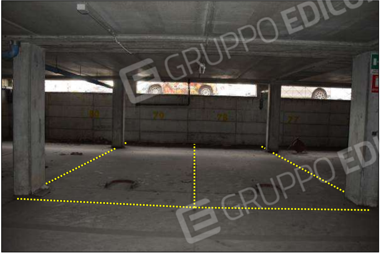
FOTO 1 – SUB 89 (POSTO 79) / SUB 90 (POSTO 78)
