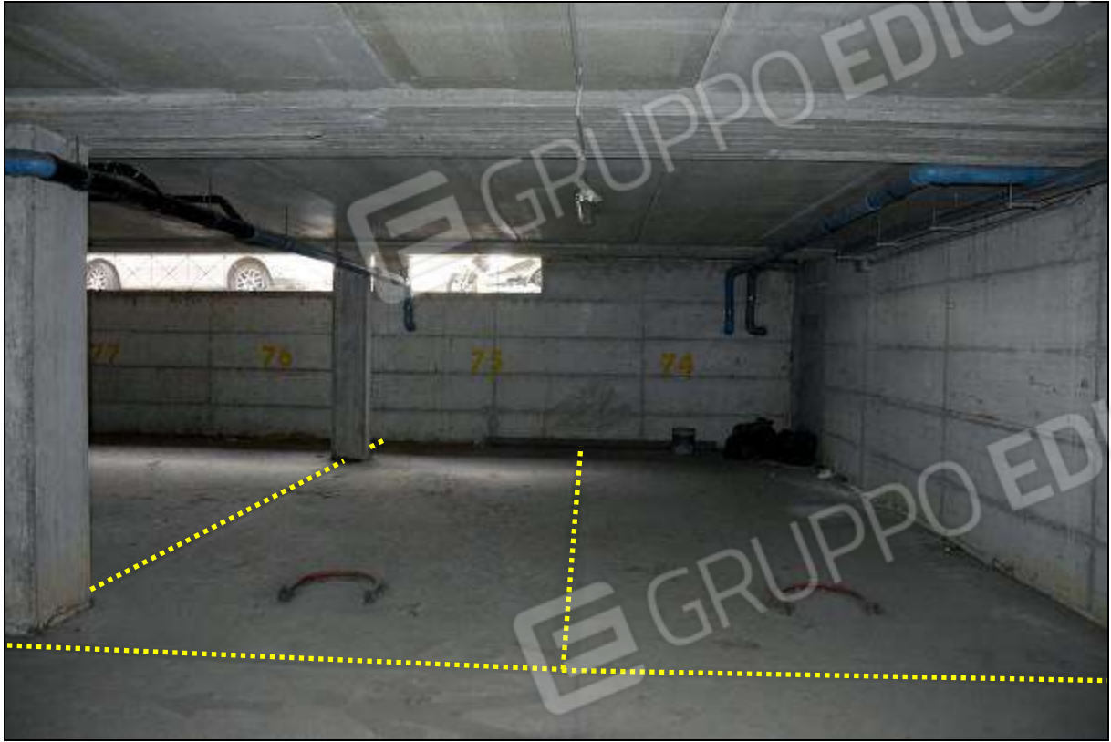
FOTO 1 – SUB 93 (POSTO 75) / SUB 94 (POSTO 74)
