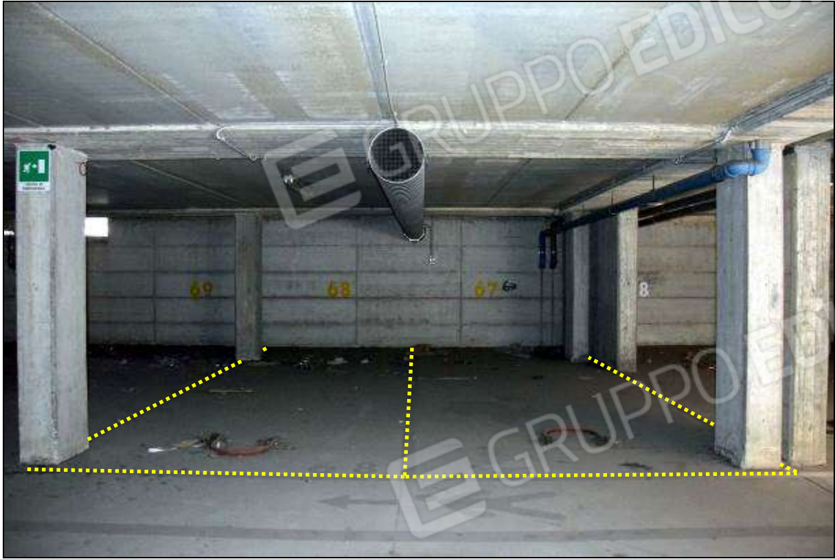
FOTO 1 – SUB 100 (POSTO 68) / SUB 101 (POSTO 67)
