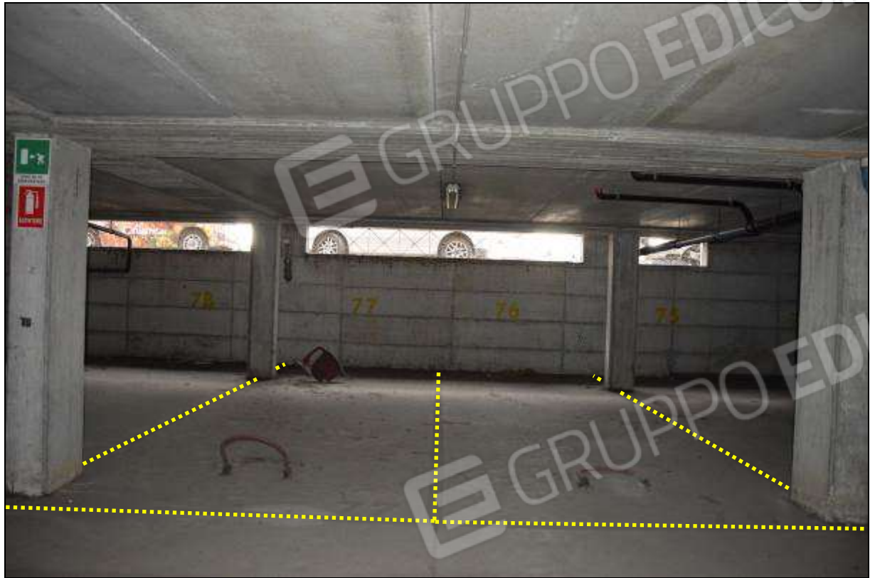
FOTO 1 – SUB 91 (POSTO 77) / SUB 92 (POSTO 76)
