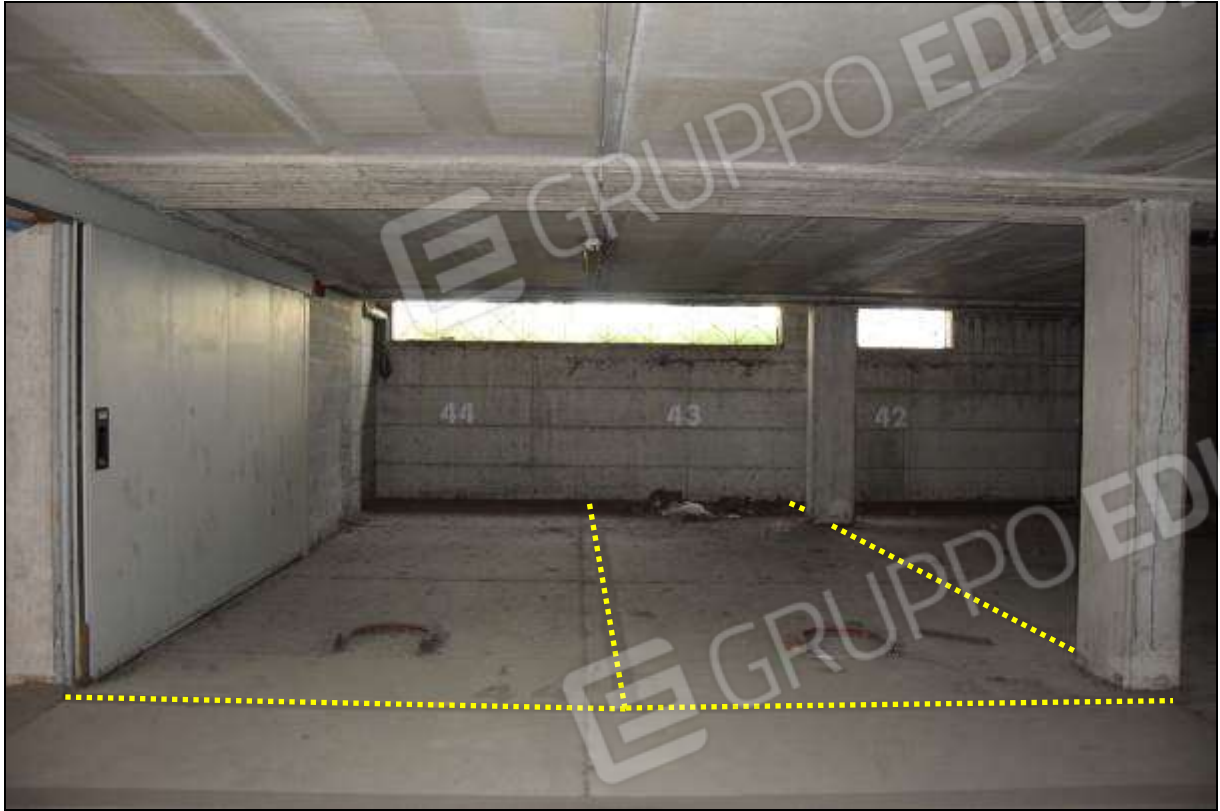
FOTO 1 – SUB 106 (POSTO 44) / SUB 107 (POSTO 43)
