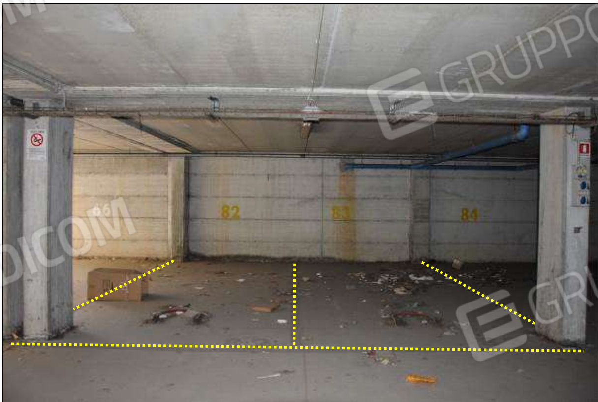
FOTO 2 – SUB 69 (POSTO 82) / SUB 70 (POSTO 83)
