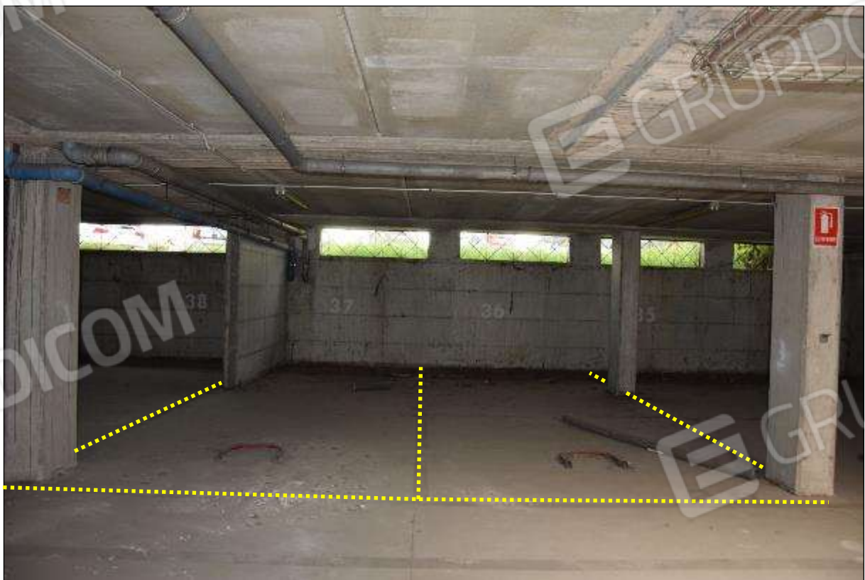
FOTO 2 – SUB 113 (POSTO 37) – SUB 114 (POSTO 36)
