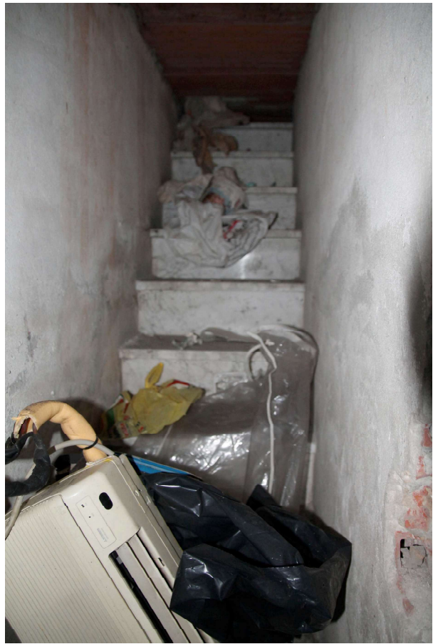
Figura 6. Scala di collegamento interrato e piano terra
