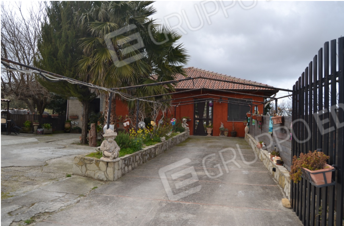
Fotografia 5 – Ingresso corte di pertinenza da cancello carrabile.
