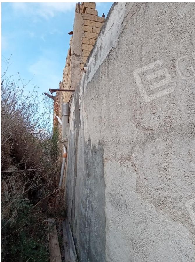
Foto 6: "Altro prospetto laterale"
