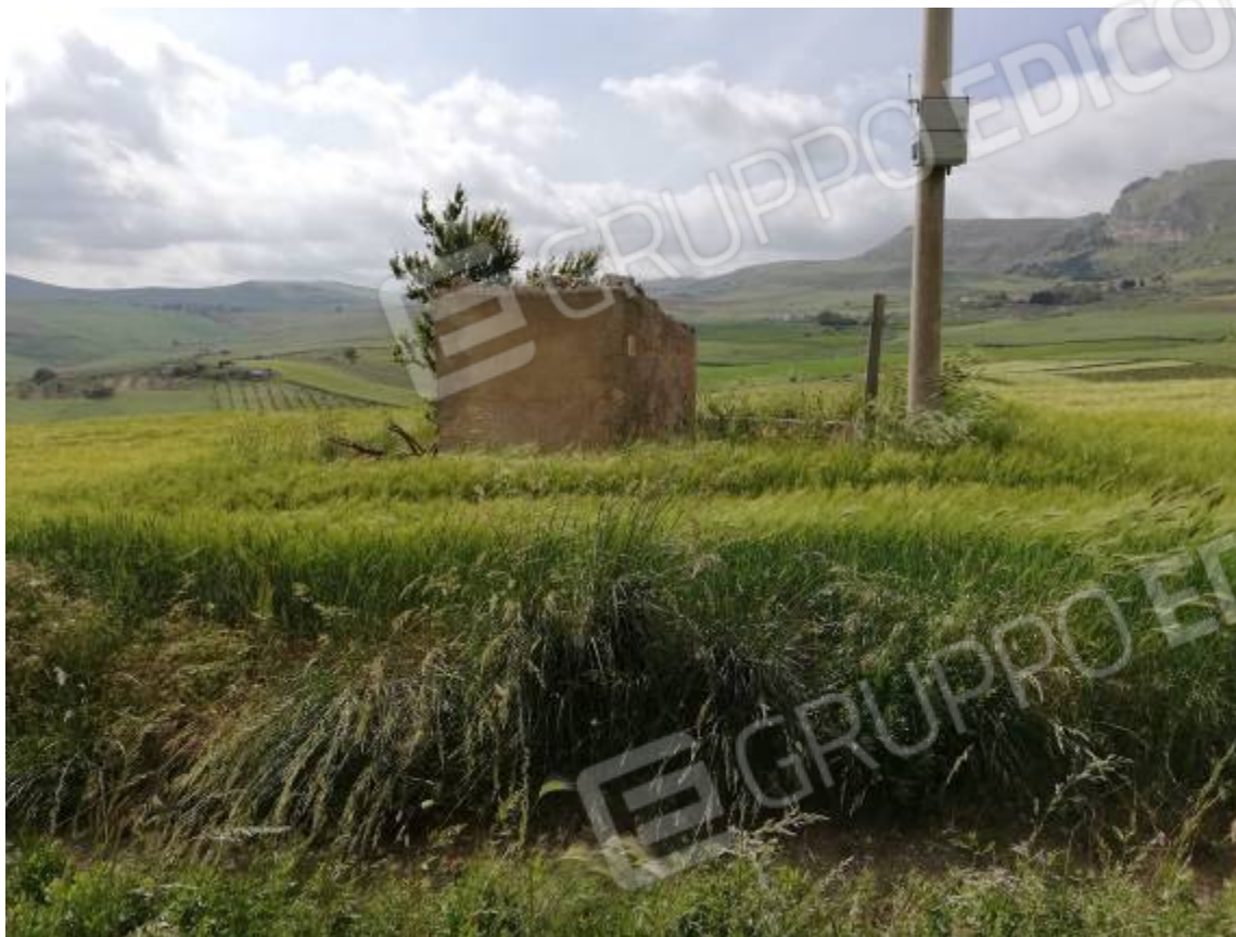
Foto n. 3 – Piccolo fabbricato insistente sulla p.lla 134
