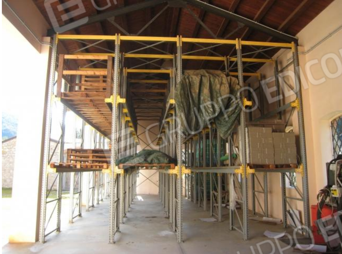
Foto n. 104. L'interno del portico.
