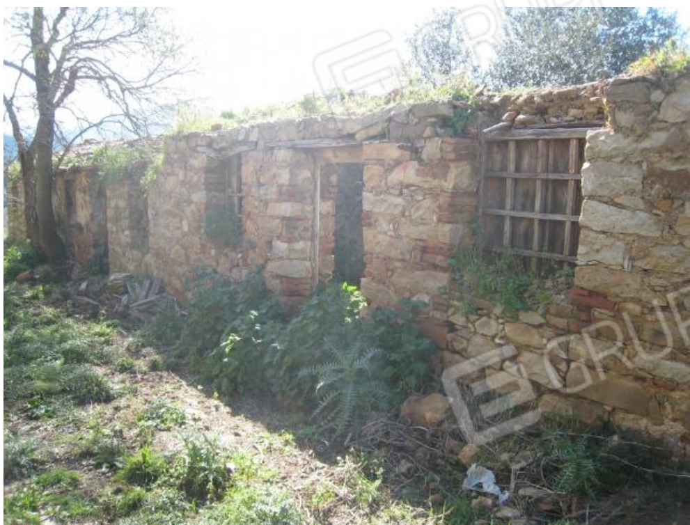
Foto n. 73. Altra immagine del prospetto principale del fabbricato ad una sola elevazione.
