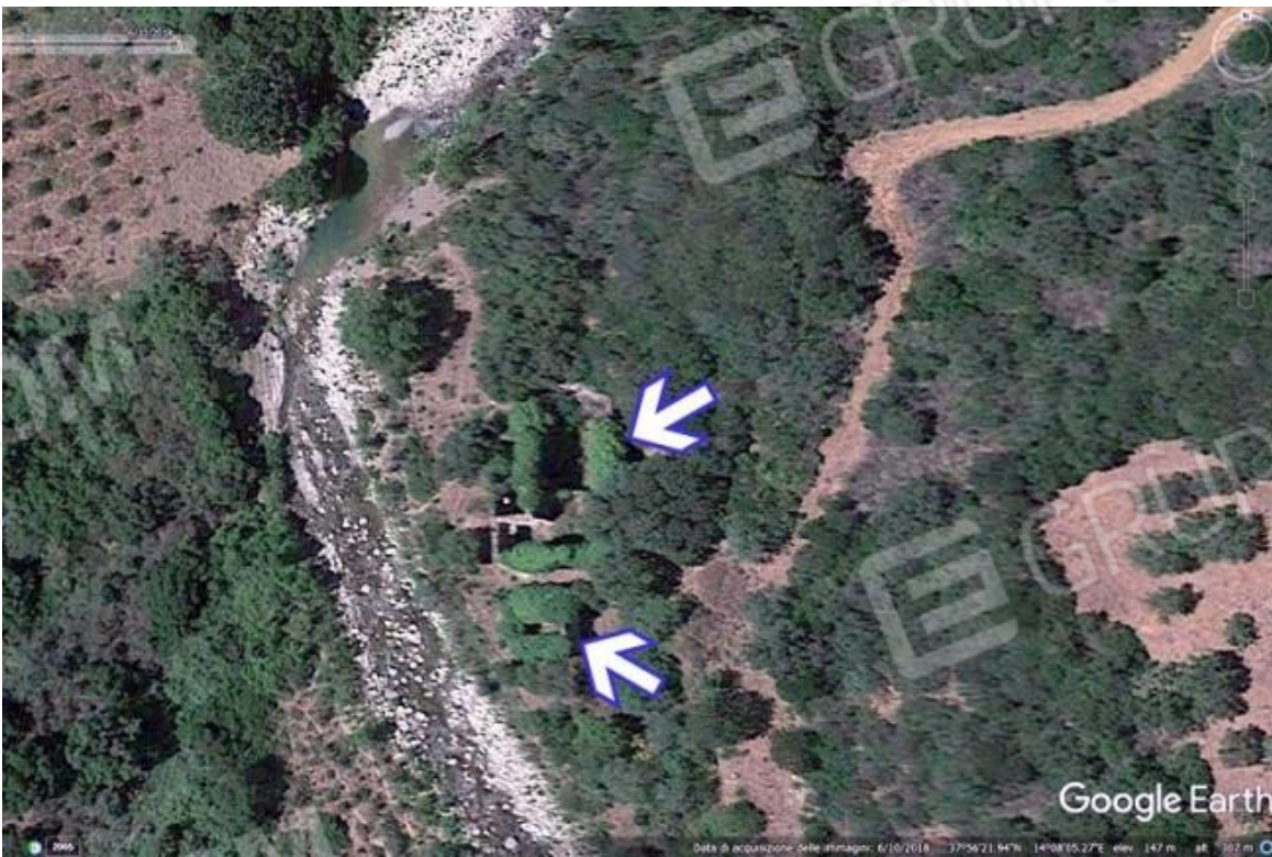
Foto n. 75. Posizione dei due fabbricati e loro consistenza.
