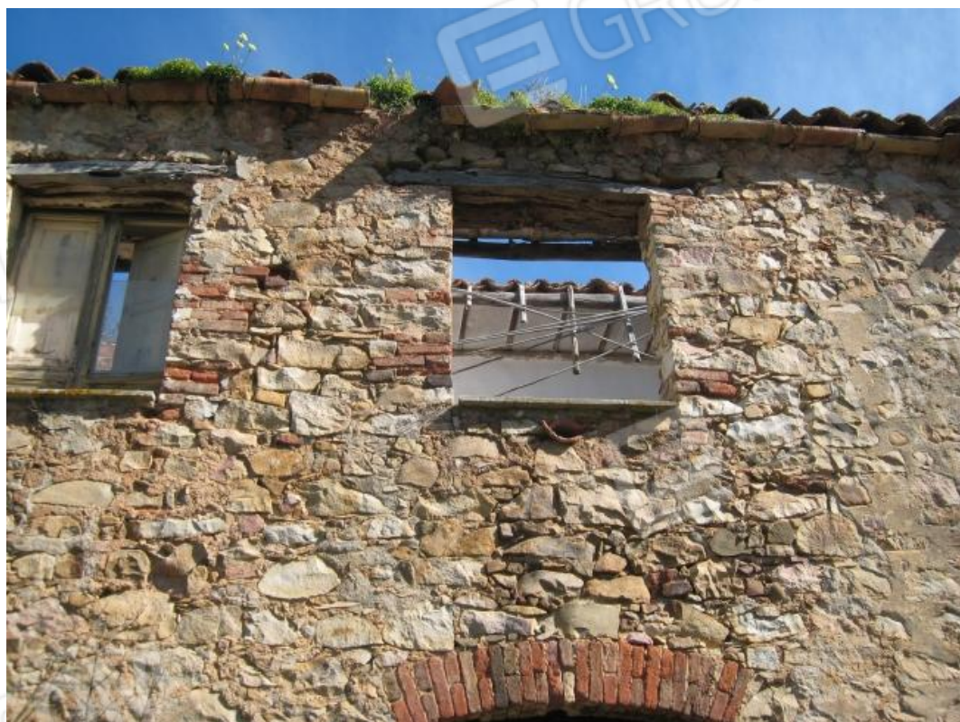
Foto n. 69. Condizioni di muratura ed infissi.
