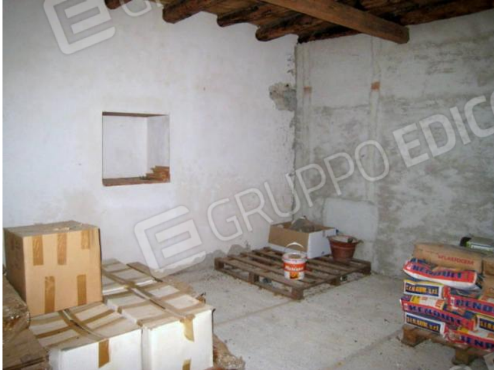
Foto n. 20. Locali in ristrutturazione.
