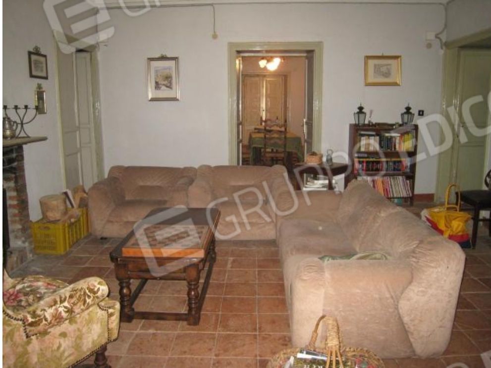
Foto n. 37. Il salotto di piano primo. L'impianto elettrico è a vista.
