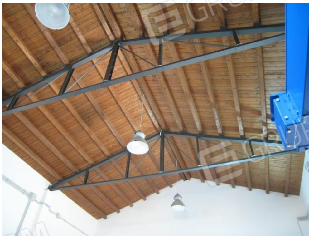
Foto n. 113. Copertura del frantoio.
