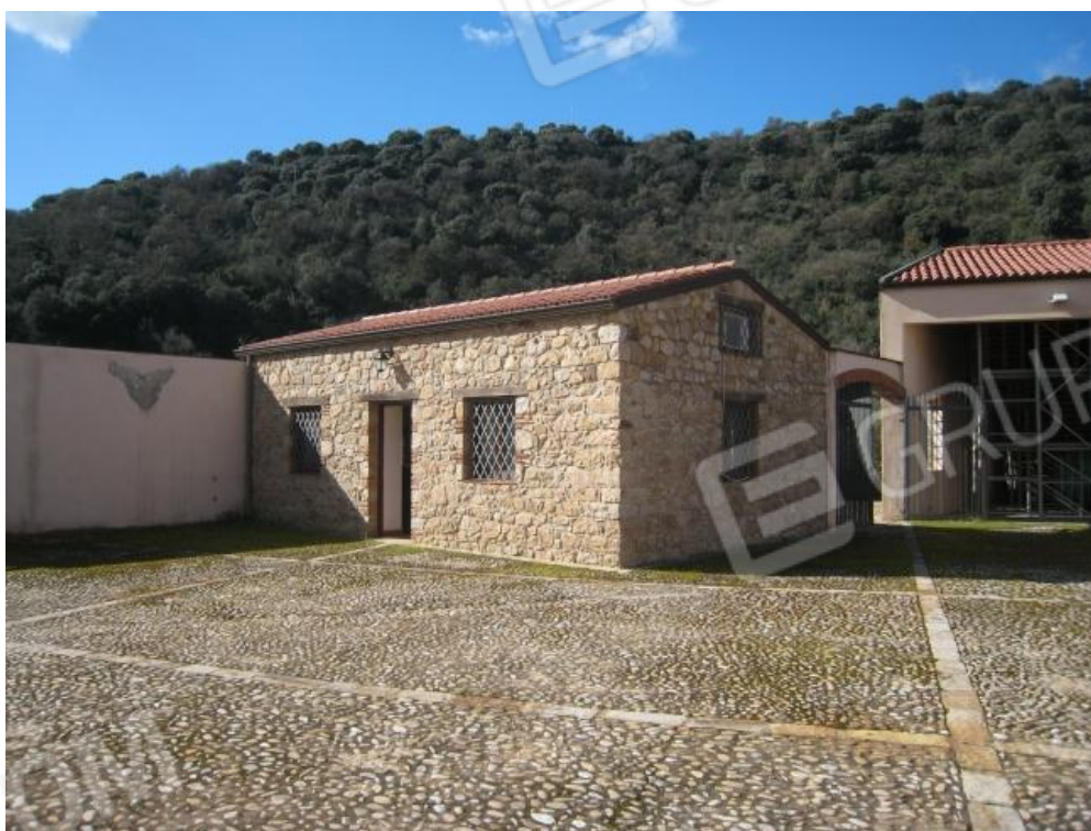
Foto n. 101. Dettaglio del fabbricato adibito ad ufficio.
