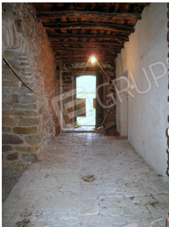
Foto n. 27. Il corridoio al P.T., sub 2 (bene comune non censibile)
