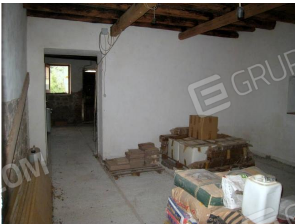
Foto n. 19. Locali al P.T. del corpo "B" in fase di ristrutturazione interna.
