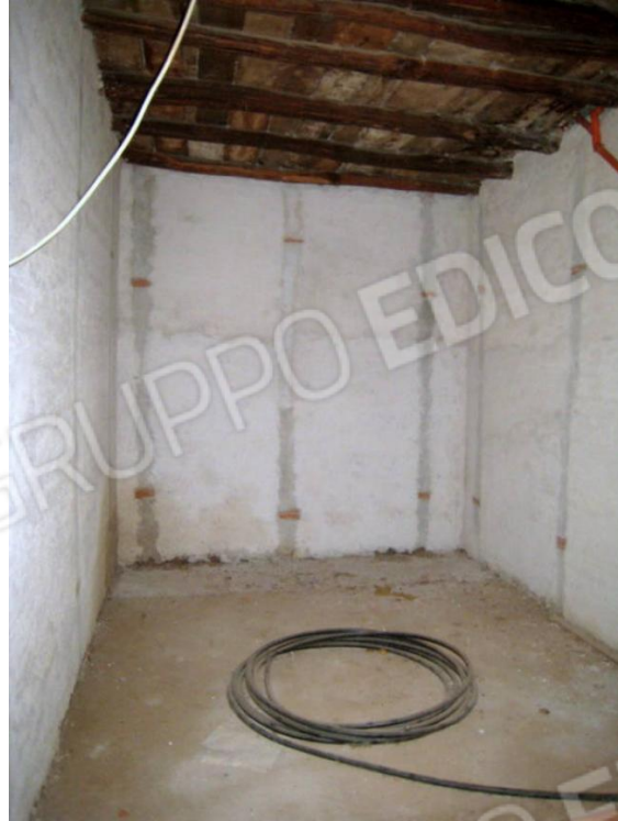
Foto n. 29. Altra piccola stanza del sub 4 (unità collabente) in fase di restauro.
