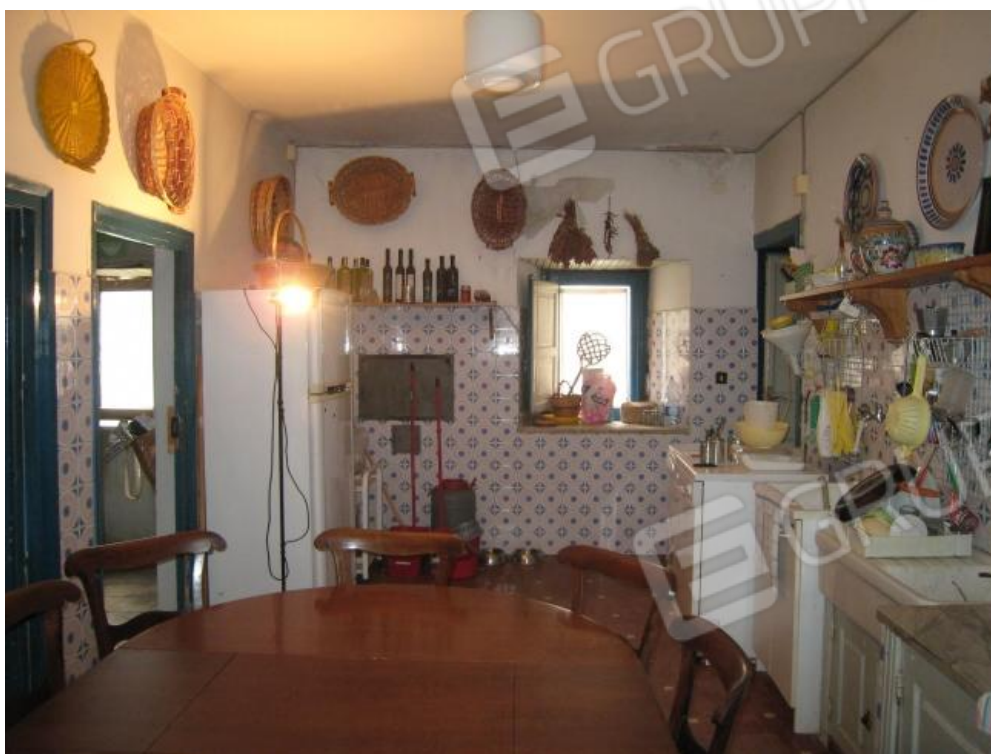
Foto n. 40. Sempre la cucina. Tracce di umidità al soffitto ed impianto elettrico a vista.
