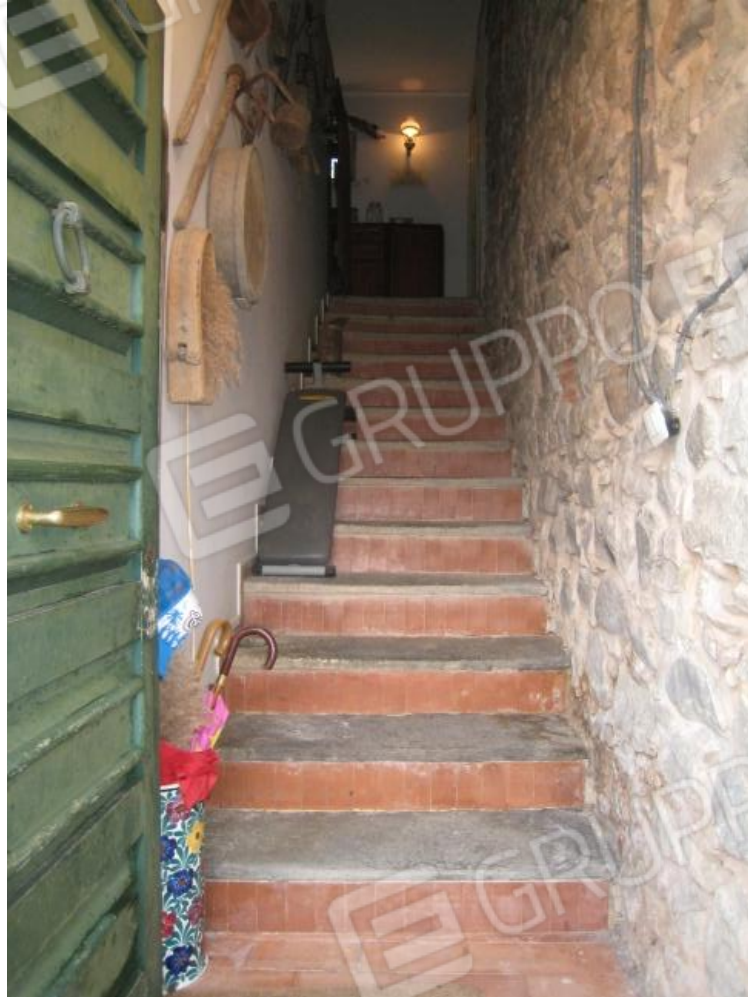
Foto n. 32. La scala di accesso al primo piano.
