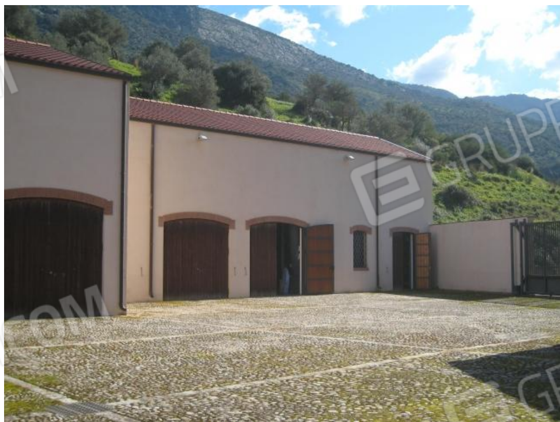
Foto n. 99. Imbottigliamento, deposito confezioni, magazzino e cancello di accesso carraio.
