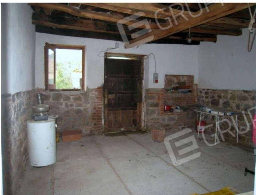
Foto n. 21. Altra stanza in fase di recupero.
