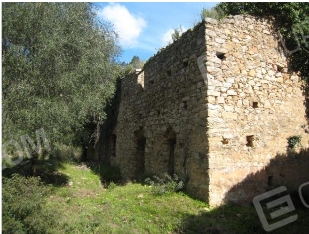
Foto n. 76. Il fabbricato più grande.
