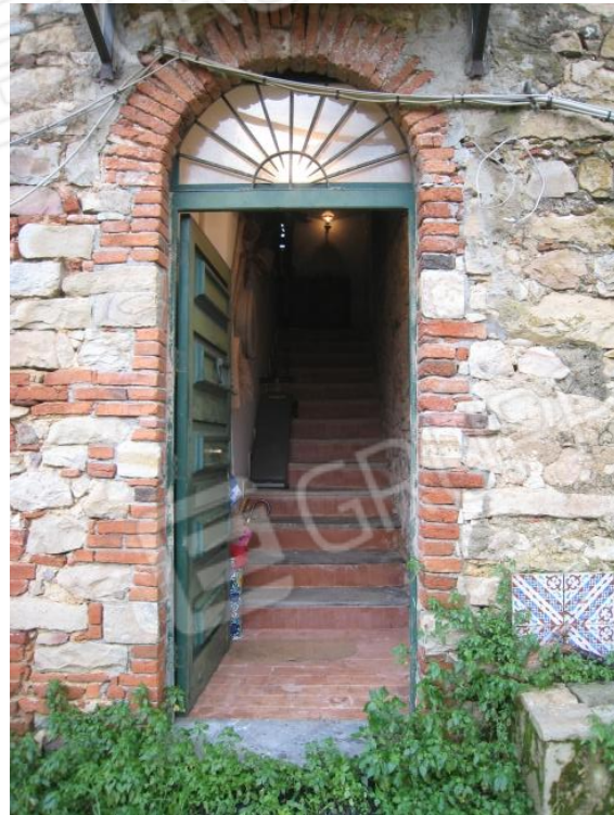
Foto n. 31. Il portone di ingresso all'unità di piano primo, corpo "B".
