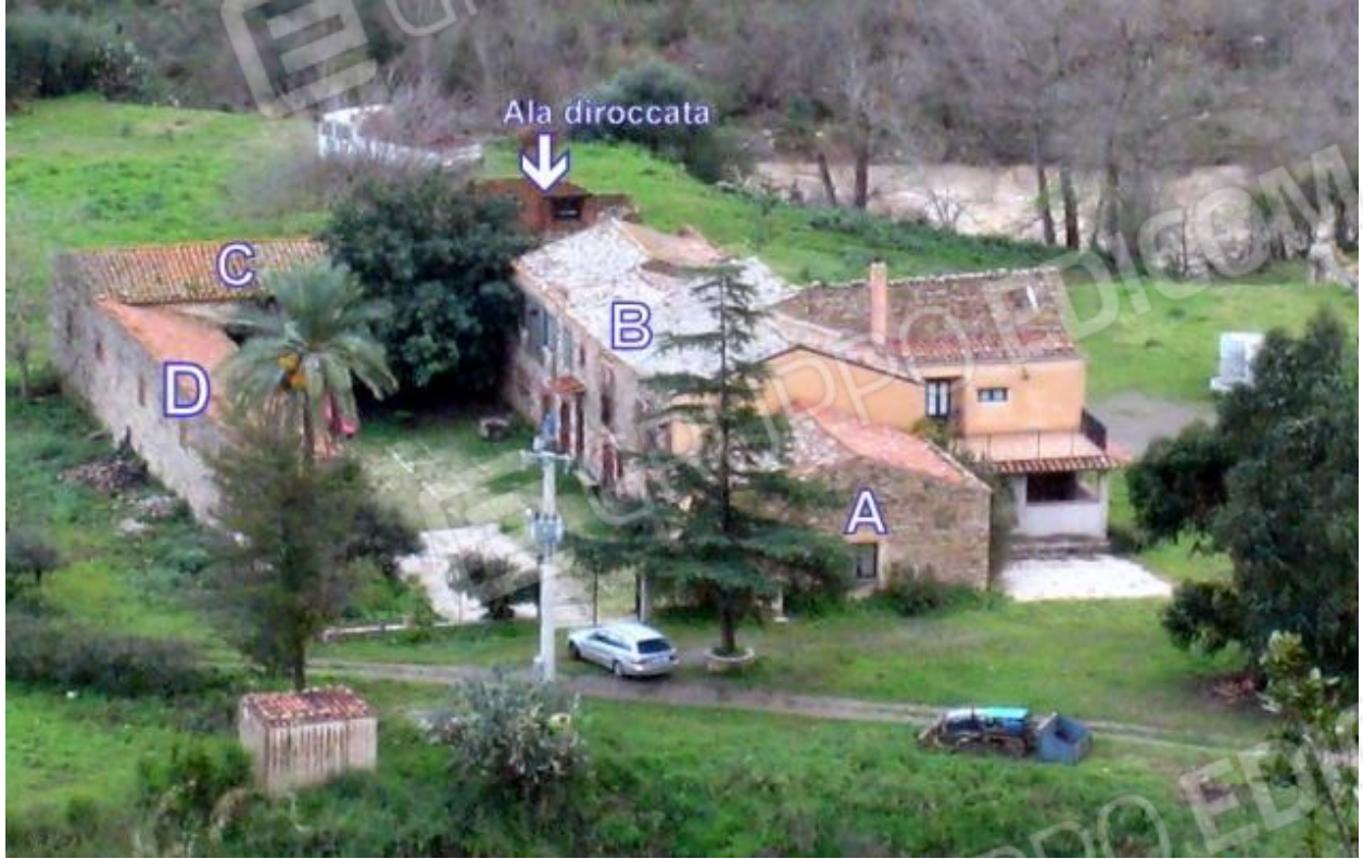
Foto n. 51. Panoramica del Baglio Tornisia.
