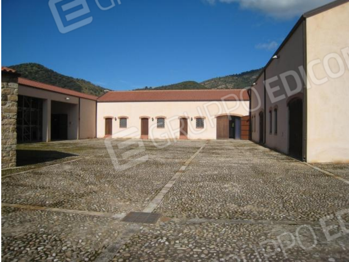
Foto n. 98. Il cortile: a Sx il portico; al centro la stanza operai, la sala conferenze, la sala riunioni; a Dx il frantoio con i silos.
