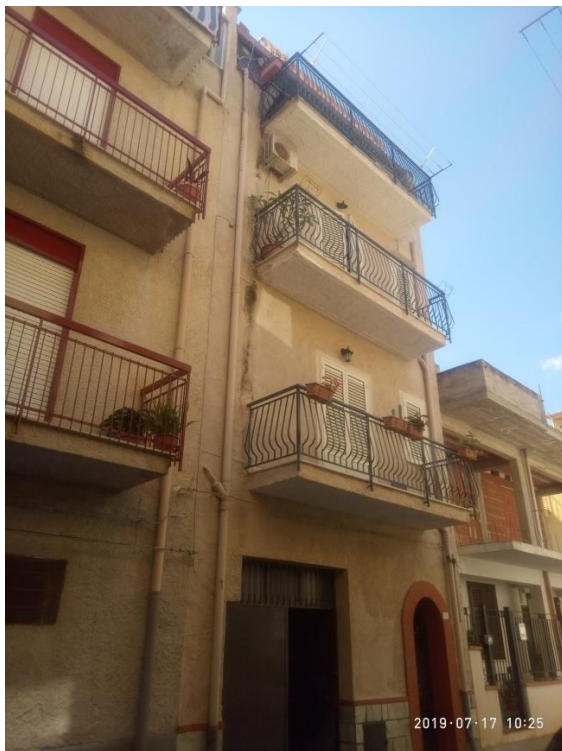
Prospetto principale su via Monfalcone. Unici affacci dell'immobile
