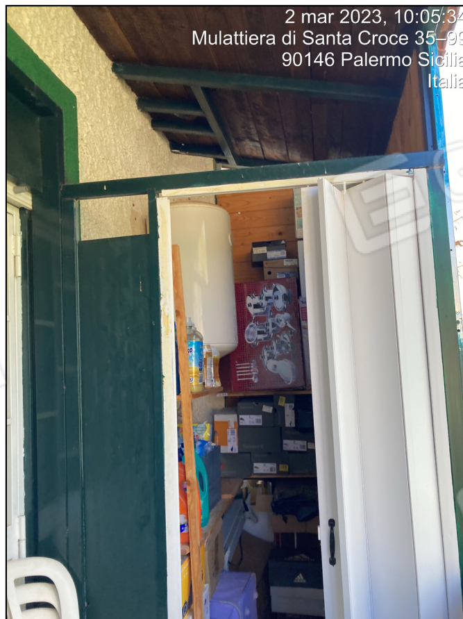
Foto n. 16 - Interni: balcone con tettoia e ripostiglio del primo appartamento
