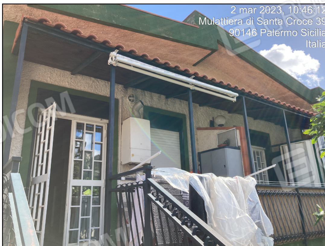
Foto n. 26 - Esterni: balcone sul retro
