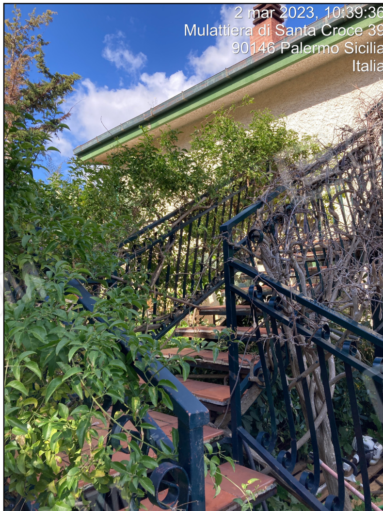
Foto n. 6 - Scala esterna di accesso al primo appartamento
