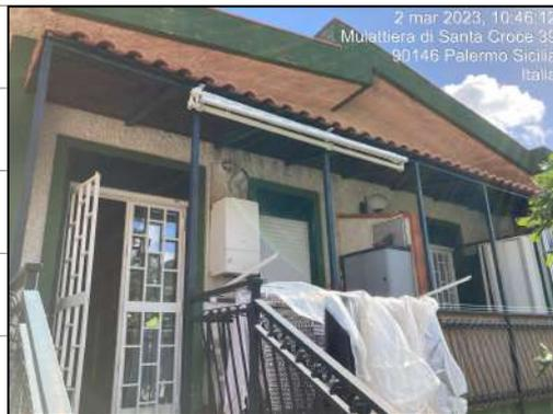
Gli infissi esterni sono in alluminio con vetro camera, dotati di serrande in pvc e di grate metalliche all'esterno. Gli infissi interni sono in legno.
