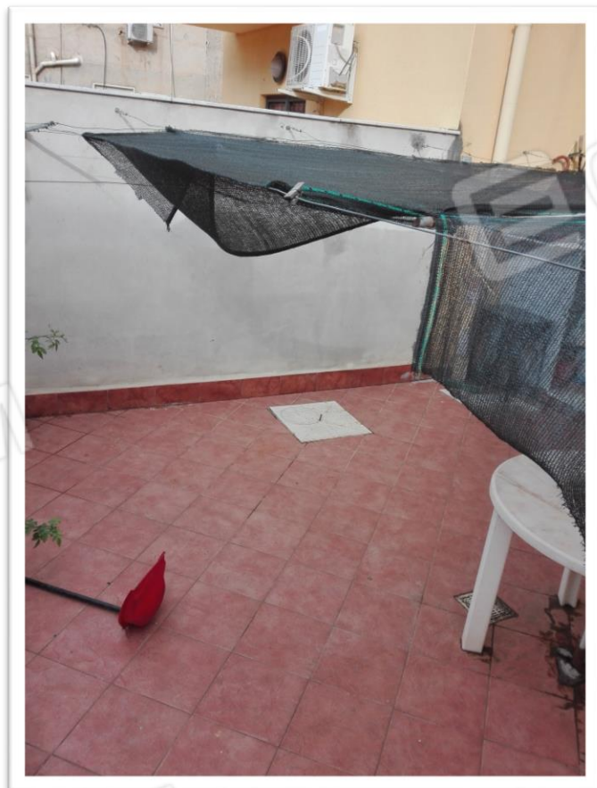
Foto 29 particolare pavimentazione terrazzo
