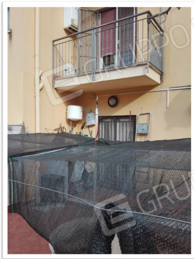
Foto 28 particolare retro prospetto
