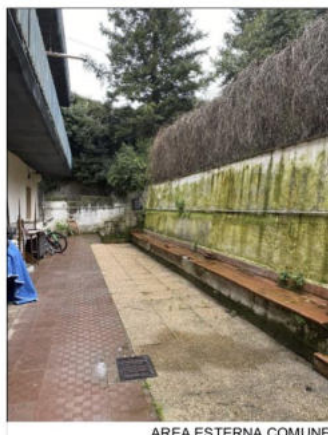
AREA ESTERNA COMUNE
