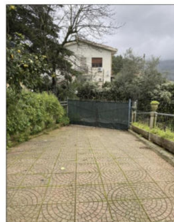
ACCESSO SU VIA SM3
