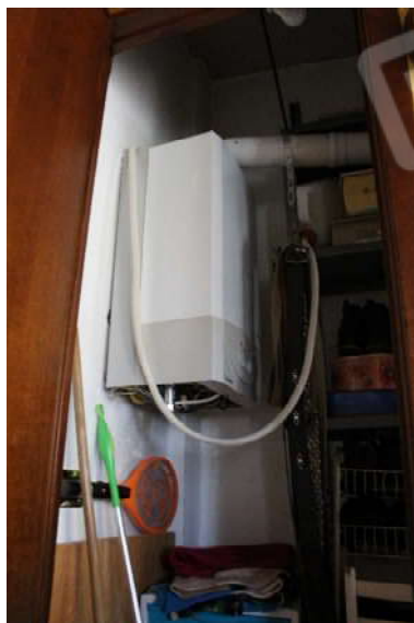
Foto n°19: Veranda con vano Ripostiglio.
