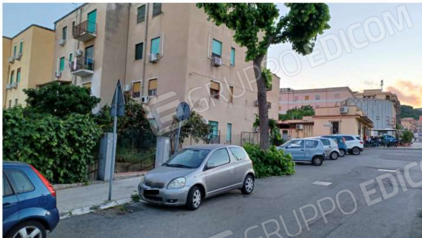
FOTO 5 – PROSPETTO DAL CONTROVIALE DEL VIALE ANNUNZIATA
