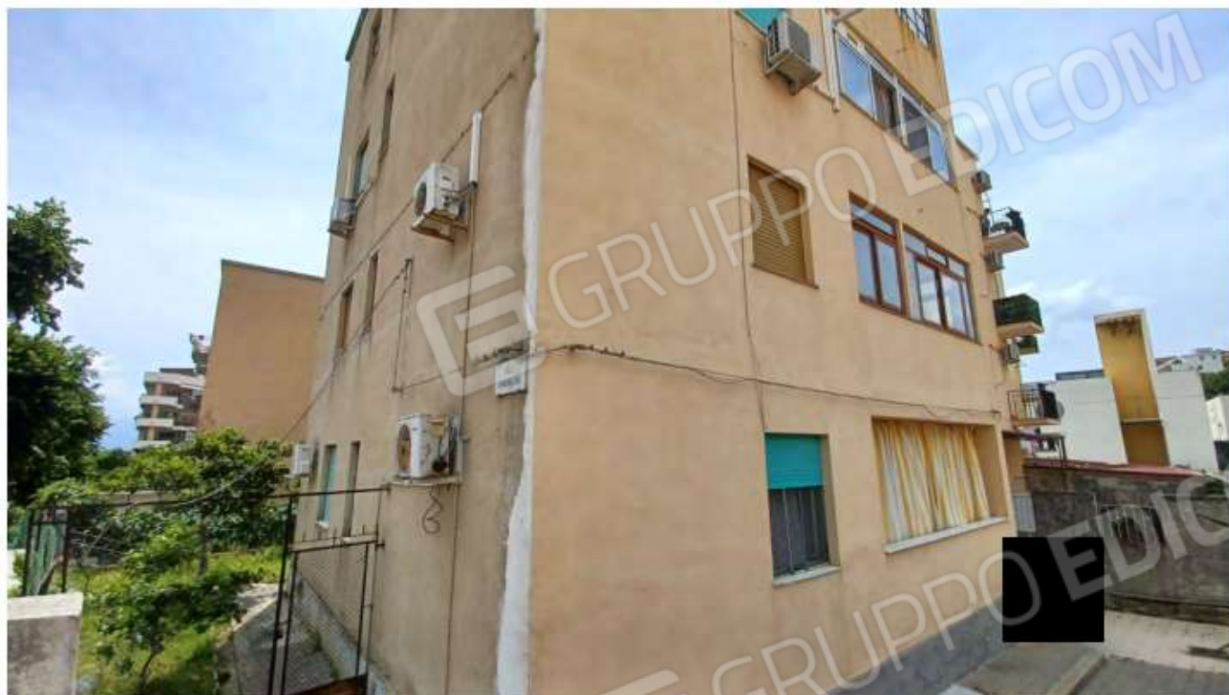
FOTO 7 - PROSPETTO SU AREA CONDOMINIALE DI INGRESSO
