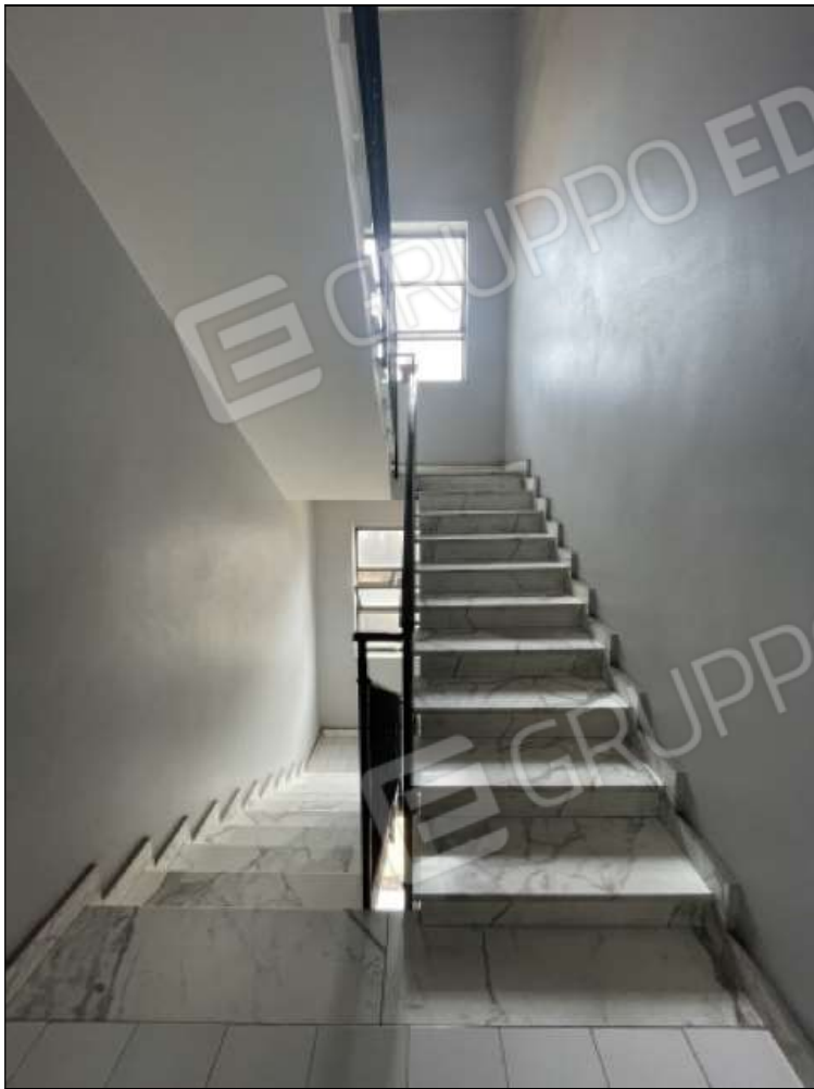
foto 07 - Vano scala condominiale
