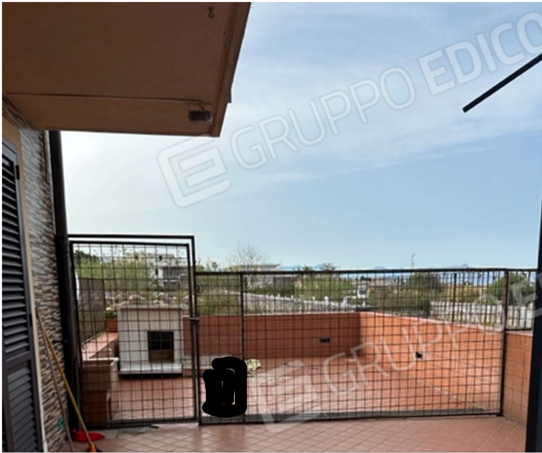
FOTO 10_terrazzo piano terra lato est
