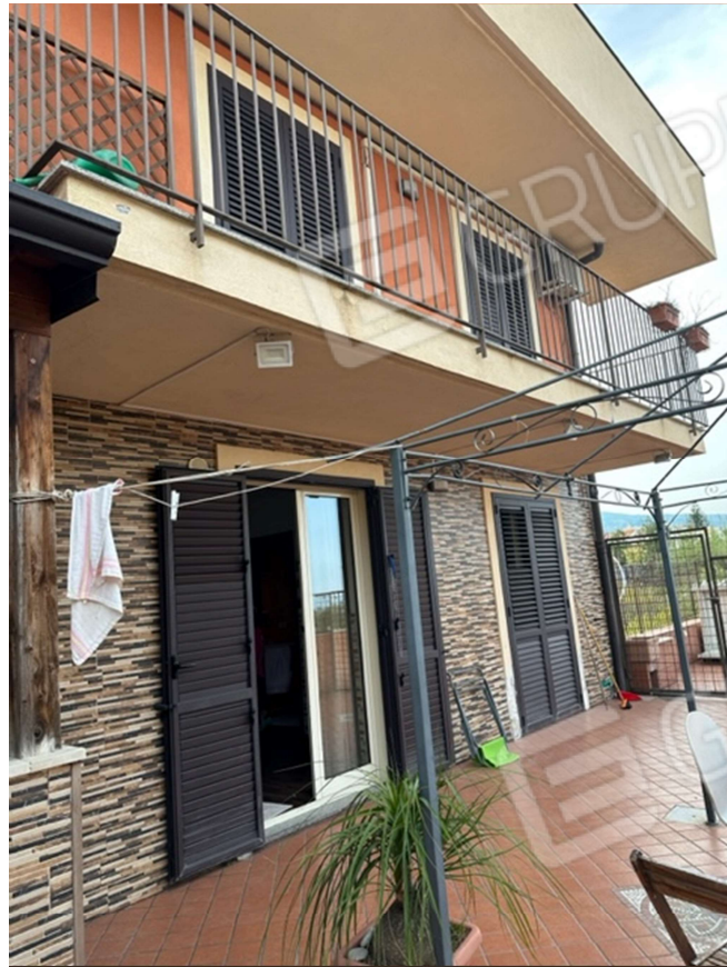
FOTO 11_terrazzo piano terra lato est
