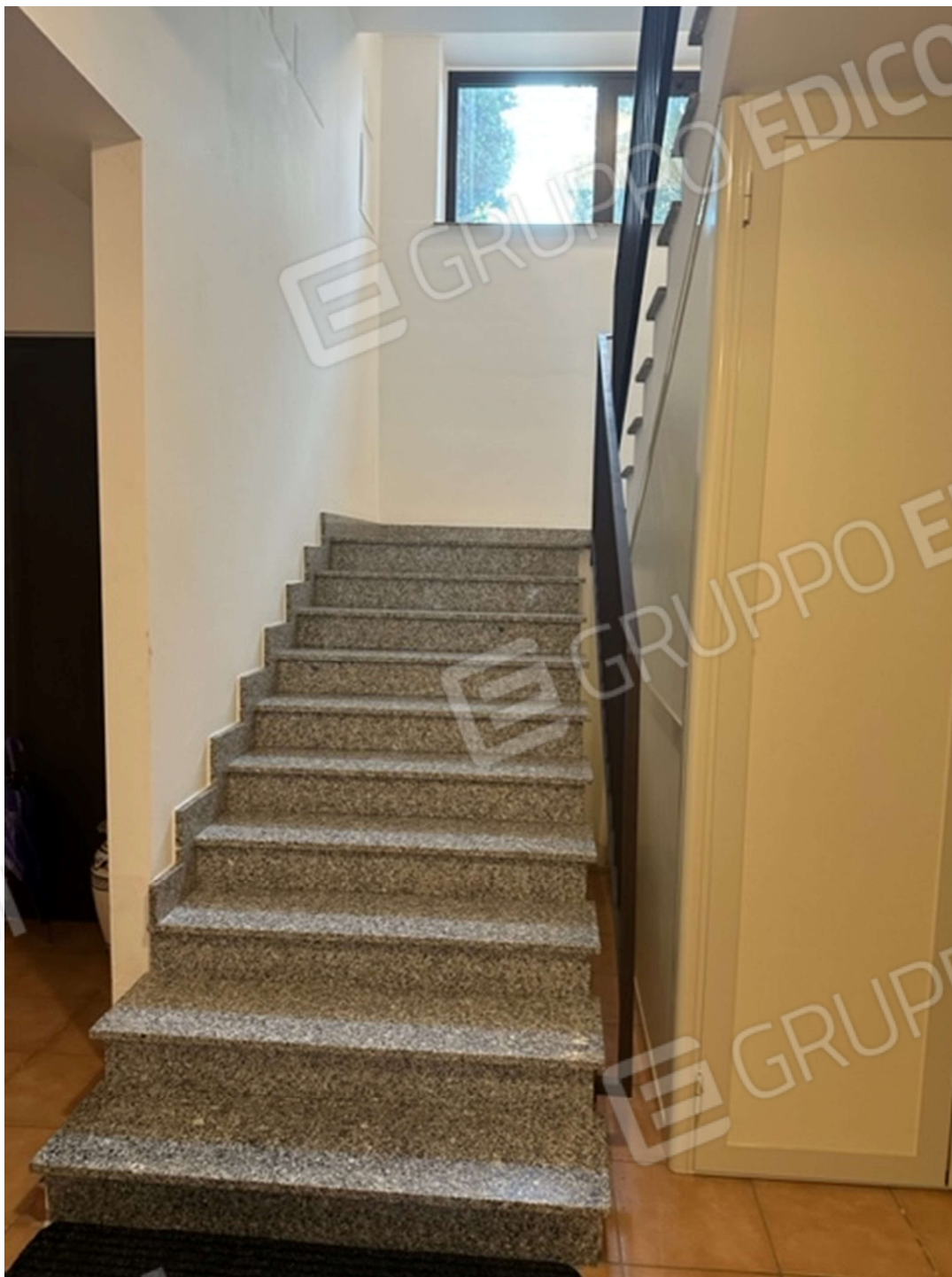
FOTO 7_ vano scala comune
