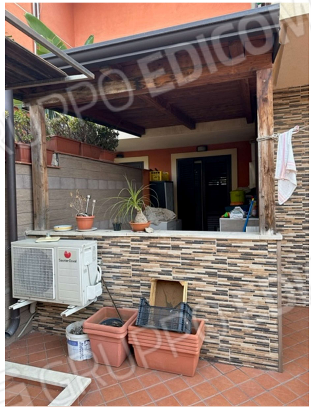
FOTO 12_ terrazzo piano terra tettoia non in regola
