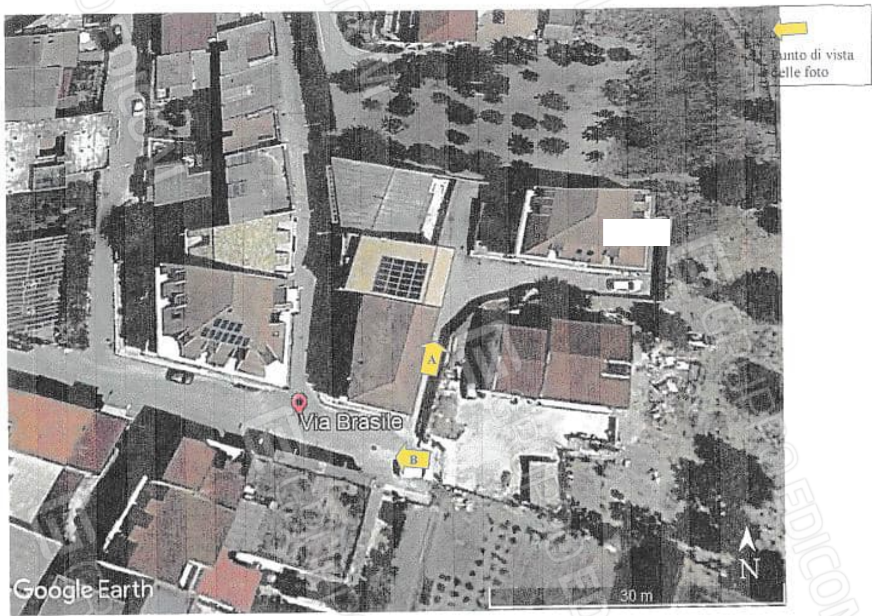
Contesto urbanistico nell'immediate vicinanze dell'Autorimessa, ubicato in via Brasile a Canicatti
