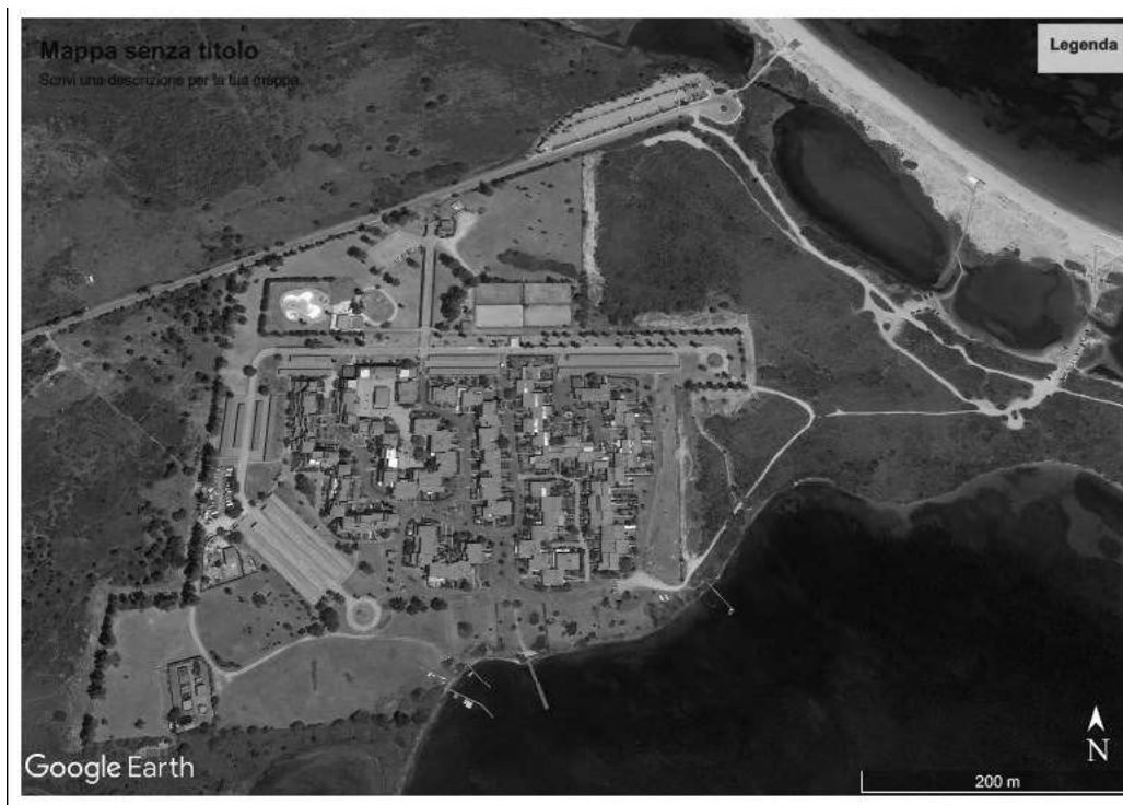
Foto aerea condominio Baia turchese
