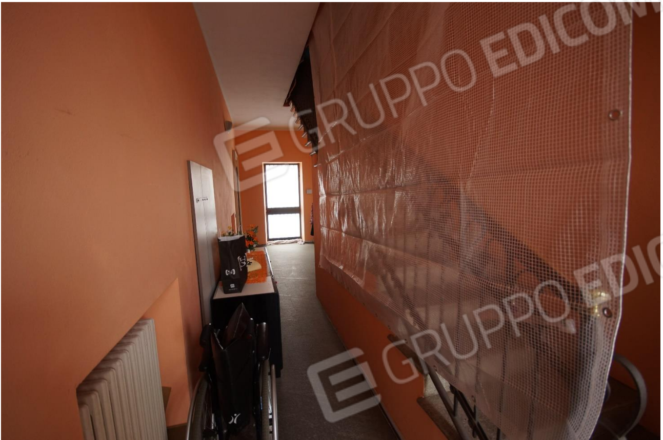
Interno vano scala piano terra
